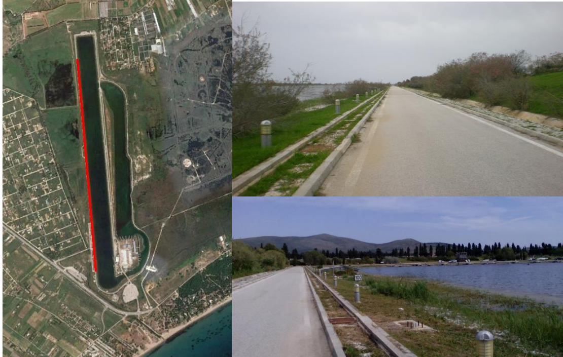
Εικόνα 3.10 Περιοχή εγκατάστασης της βάσης
