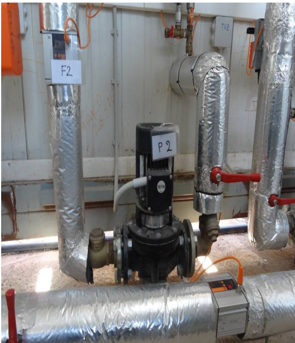
Εικόνα 3.2 Μετρητές ροής
