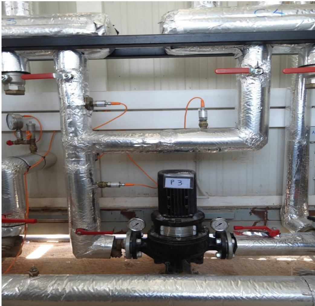
Εικόνα 3.3 Αισθητήρες θερμοκρασίας στο τεχνικό δωμάτιο
