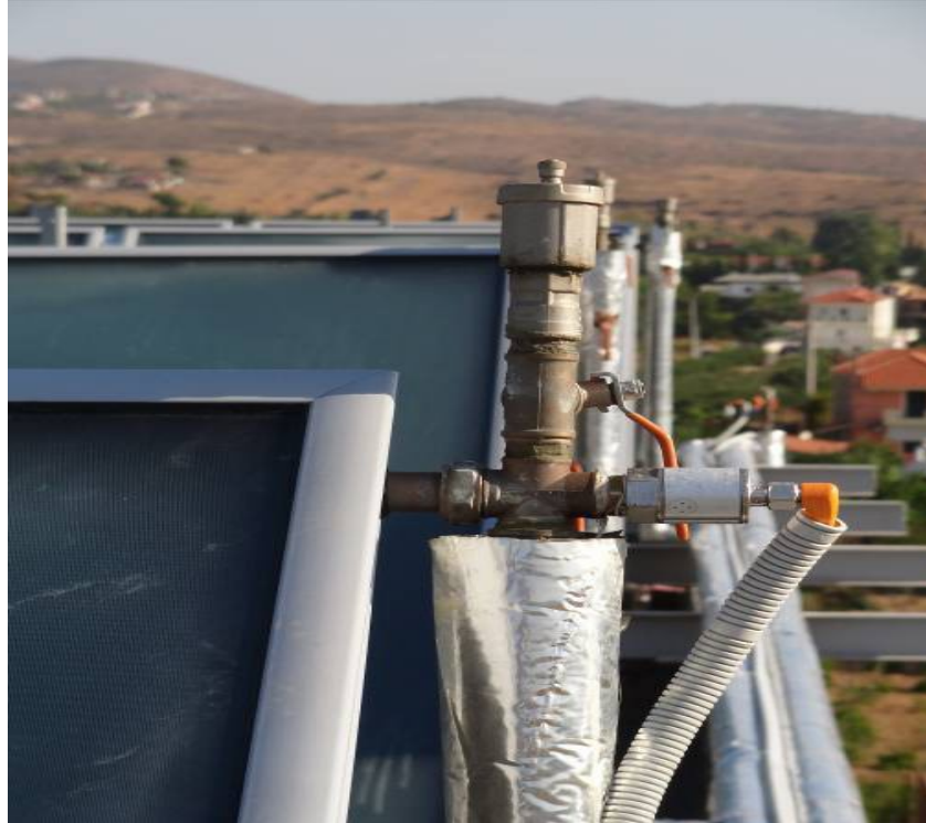
Εικόνα 3.4 Αισθητήρες θερμοκρασίας στο ηλιακό πεδίο
