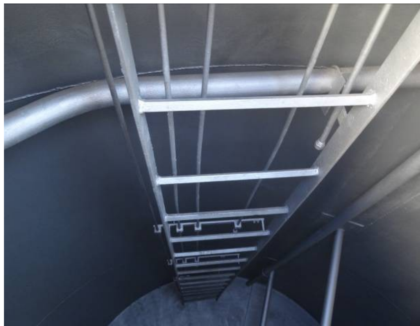
Εικόνα 3.5 Αισθητήρες θερμοκρασίας στη δεξαμενή
