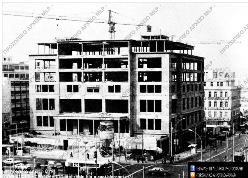
Σχ.3.1: Φωτογραφική λήψη από την ανέγερση του κτιρίου το 1969
