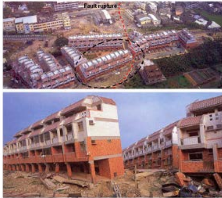
Εικόνα 2.4: Τετραώροφο κτίριο σε σχετικά εύκαμπτη θεμελίωση στην πόλη Fung-Yan, το οποίο επέζησε από ανύψωση του εδάφους ίση με 6 μέτρα, στο σεισμό του 1999 στο Chi-Chi της Taiwan, αλλά με σημαντικές δομικές ζημιές. Η ολόσωμη μετακίνηση του κτιρίου κυμάνθηκε από 4 έως 7 μοίρες. (από Faccioli et al., 2008)
