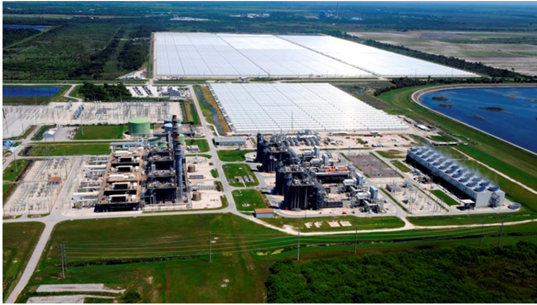
Σχήμα 2.20: Εγκατάσταση συμπαραγωγής Martin Next Generation Solar Energy Center
