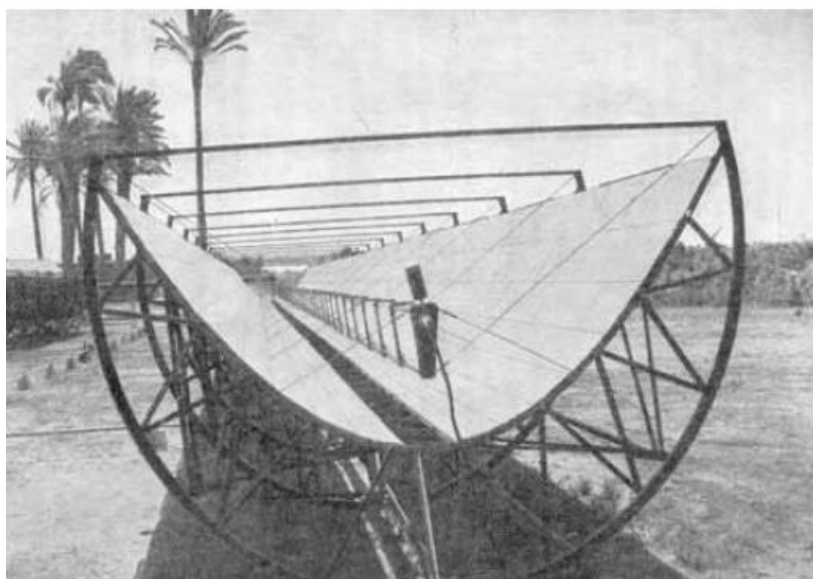
Σχήμα 2.12: Ένας από τους 5 PTC συλλέκτες της εγκατάστασης [7]
