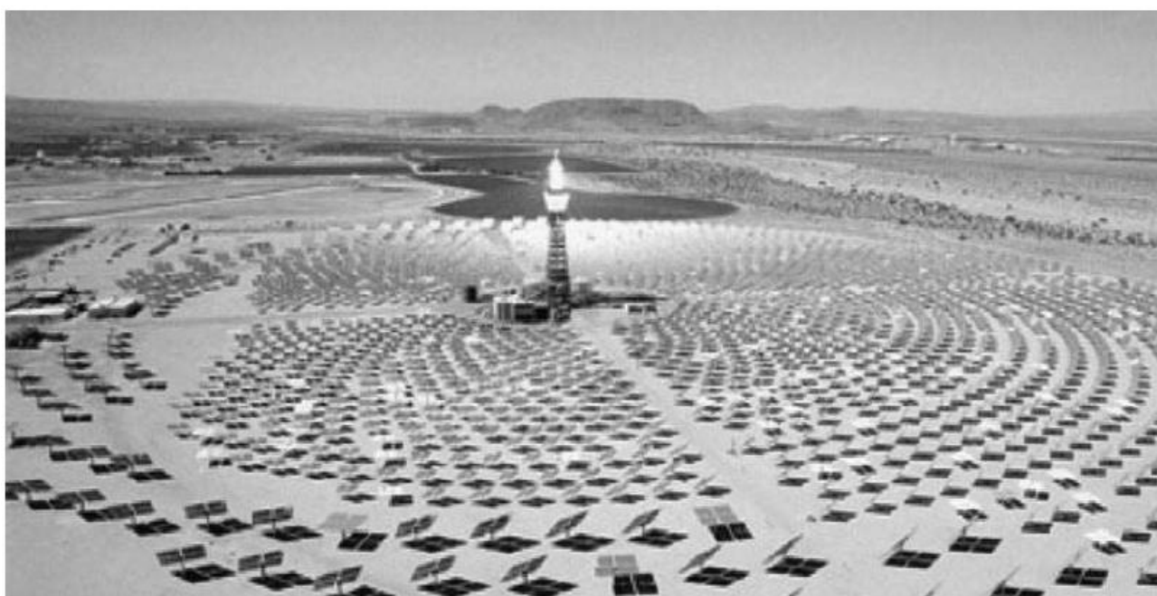
Σχήμα 2.3: Εγκατάσταση ηλιακού πύργου [8]
