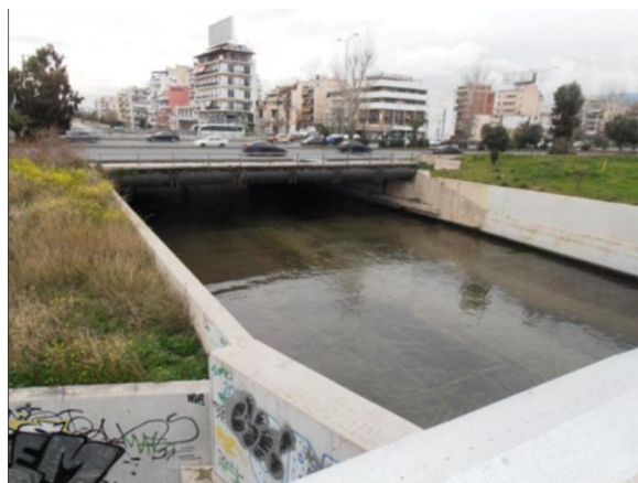
Εικόνα 70: Άποψη εκβολής Ιλισού Πηγή: http://www.econews.gr
