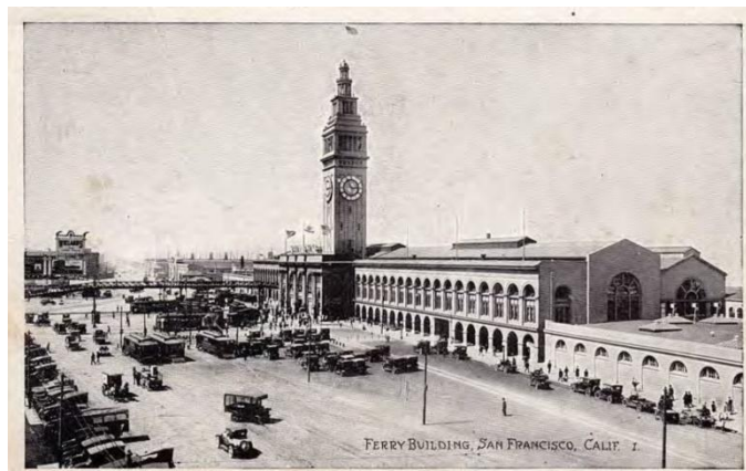
Εικόνα 20: Η Embarcadero ως απλός δρόμος στις αρχές του 20ου αιώνα Πηγή: http://www.sanfranciscodays.com
