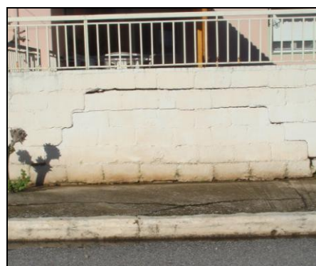
Εικόνα 2.9: Ρωγμές στην τοιχοποιία κτηρίου και στο δάπεδο οικίας, στην περιοχή Αγίου Γεωργίου, το έτος 2010.
