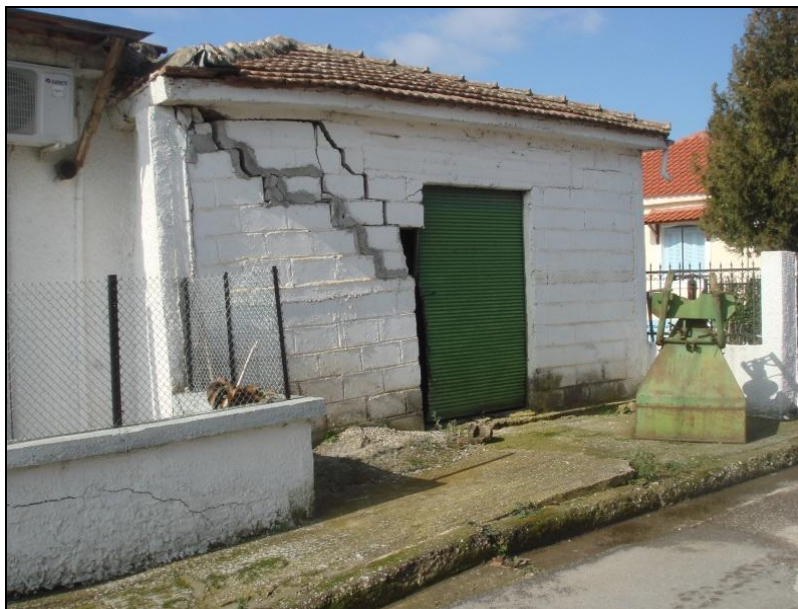
Εικόνα 2.7: Ρωγμές στην τοιχοποιία κτίσματος στην περιοχή Σταυρού του Δυτικού Θεσσαλικού κάμπου (Modis & Sideri, 2015).
