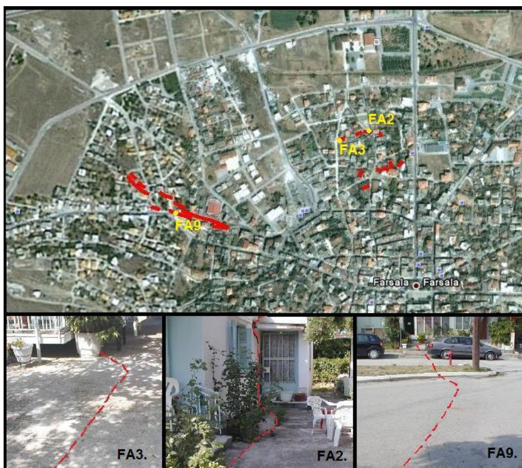
Εικόνα 2.6: Δορυφορική εικόνα (Google Earth) στην οποία παρουσιάζονται οι εδαφικές θραύσεις στην περιοχή των Φαρσάλων. Στις φωτογραφίες FA3, FA2 και FA9 φαίνονται οι ρωγμές σε τμήματα δρόμων και οικίες της περιοχής (Rozos, et al., 2010).
