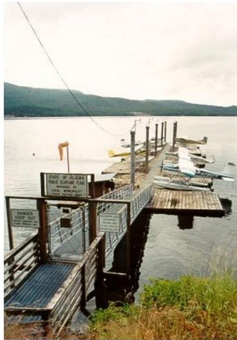
Εικόνα 3-42 Παράδειγμα διαδρόμου στην Αλάσκα (Example of a gangway in Alaska) Πηγή: [10]
