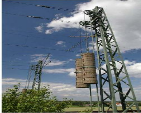
Εικόνα 11: Μηχανισμός τάνυσης των καλωδίων με εφαρμογή βάρους
