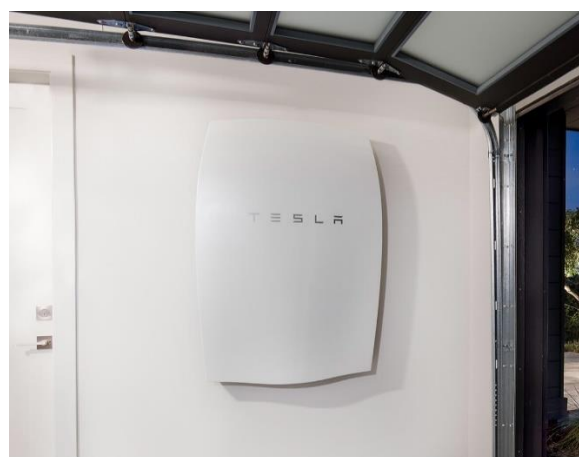
Εικόνα 3: Μπαταρία αποθήκευσης ηλεκτρικής ενέργειας για οικιακή χρήση
