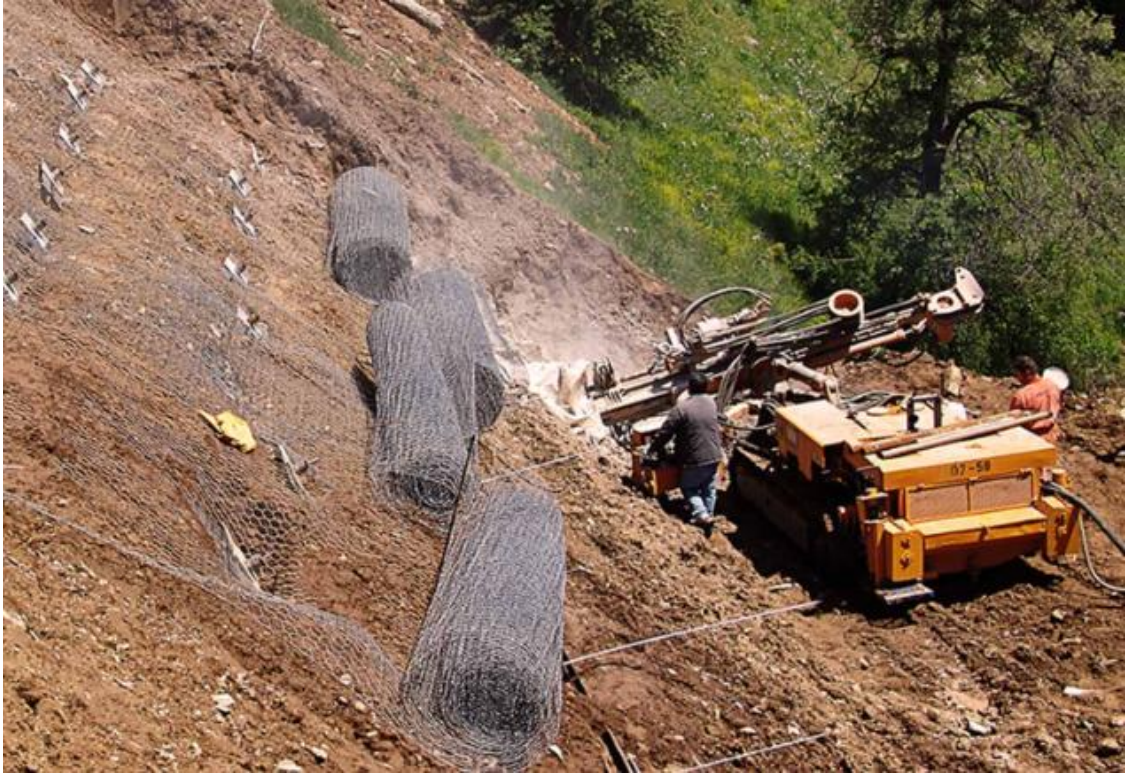
Εικόνα 5.2. Μεταλλικό πλέγμα με προεντεταμένα αγκύρια
