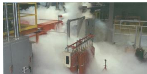
Εικόνα 10 Κατάκλυση με διοξείδιο του άνθρακα χώρου μηχανοστασίου. (πηγή: www.delaufire.com )
