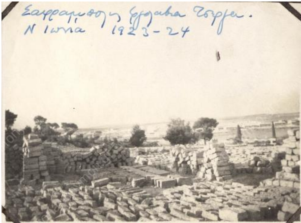
Εικόνα 8: Οικοδομικές εργασίες στην περιοχή της Σαφράμπολης 1923-24 Πηγή: Αρχείο Ένωσης Σπάρτης Μικράς Ασίας
