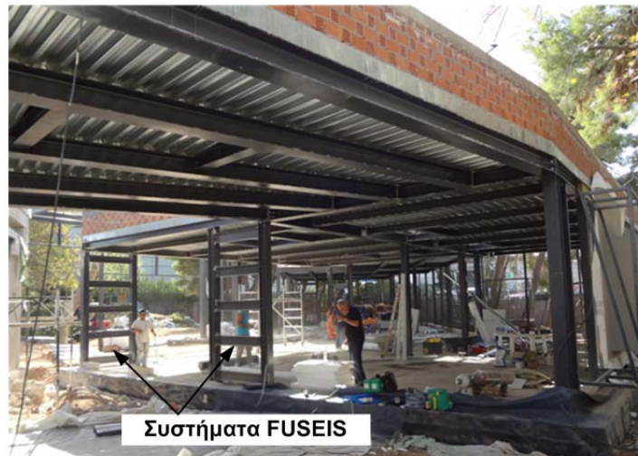
Σχήμα 3.2: Εφαρμογή συστημάτων FUSEIS1-1 στο κτίριο της ΓΣΑ
