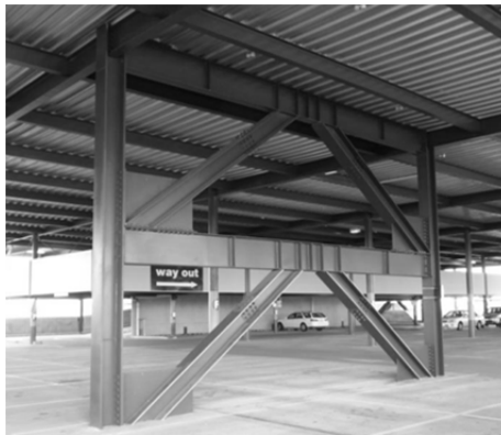
Σχήμα 1.6: Έκκεντροι σύνδεσμοι δυσκαμψίας τύπου Λ
