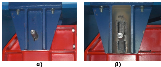
Σχήμα 3.53: Κεφαλές υποστυλωμάτων: α) πριν και β) μετά την ενίσχυση
