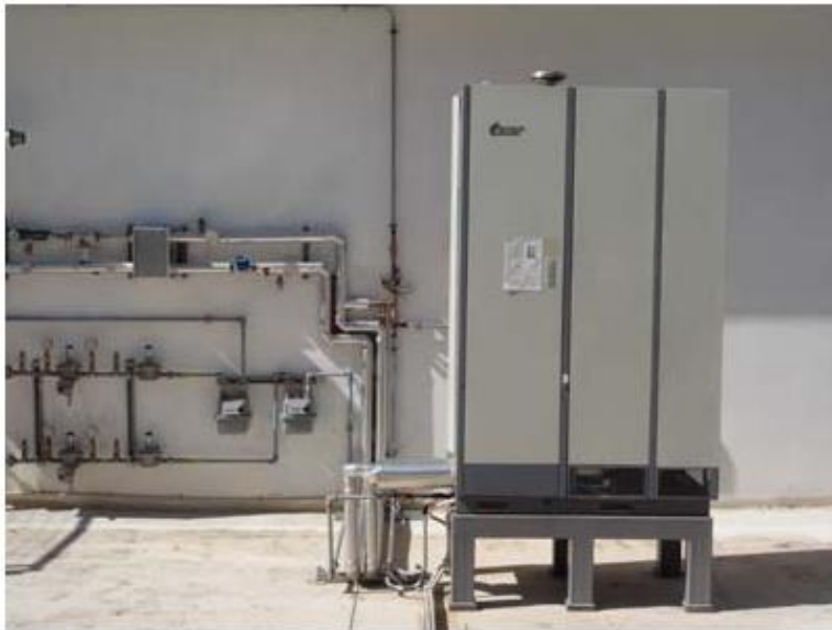
Εικόνα 2.13. Σύστημα ψύξης διβάθμιας απορρόφησης στο Ε.Μ.Π. [13]
