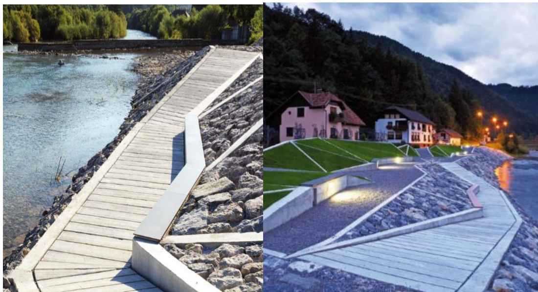
Εικόνα 7.6.η : Παραδείγματα Ξύλινης Γέφυρας επάνω σε βράχια Πηγή: Street Furniture, Chris Van Uffelen
