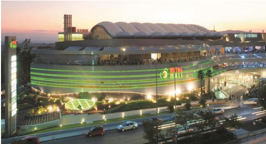
Εικόνα 6.2 Το εμπορικό κέντρο Athens Metro Mall Πηγή: athensmetromall.gr
