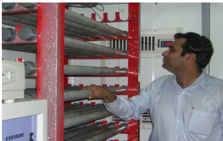
Εικόνα 3.10: Συσκευασίες υλικών αλλαγής φάσης που χρησιμοποιούνται σε τηλεπικοινωνιακά κουβούκλια
