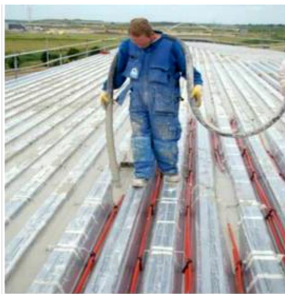
Εικόνα 4.1: Έκχυση τοιμέντου με προσμίξεις PCM στην οροφή του κτηρίου WILO, στην Ολλανδία
