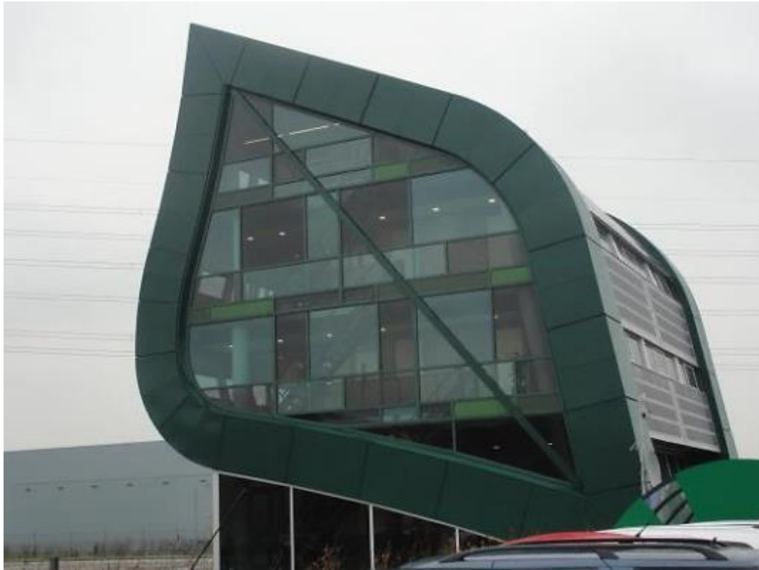
Εικόνα 4.6: Κτήριο γραφείων επιτροπής Ανανεώσιμων Πηγών Ενέργειας στην Ολλανδία, το οποίο φέρει σύστημα κλιματισμού με ενσωματωμένα PCM
