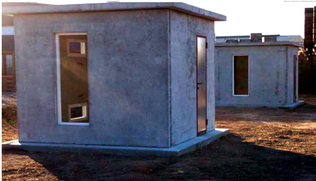
Εικόνα 4.7: Πειραματικές κατοικίες στο πανεπιστήμιο της Lleida, από οπλισμένο σκυρόδεμα με προσθήκη 5% PCM
