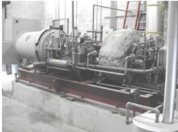
ΕΙΚΟΝΑ 2.4.5 Ο ΑΤΜΟΣΤΡΟΒΙΛΟΣ ΑΝΤΙΘΛΙΨΗΣ 1MW[15]
