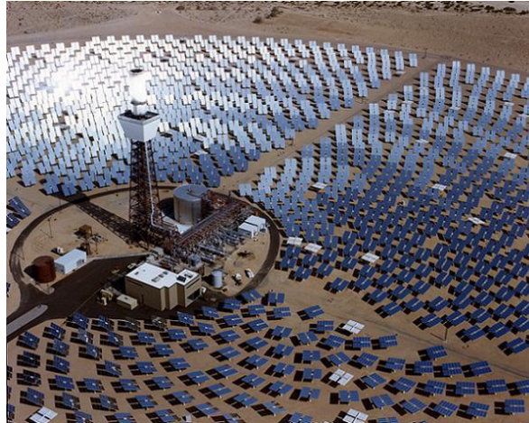
ΕΙΚΟΝΑ 5.2.2 Η ΜΟΝΑΔΑ SOLAR 2 ΣΤΗΝ ΚΑΛΙΦΟΡΝΙΑ ΜΕ ΠΥΡΓΟ ΙΣΧΥΟΣ[34]
