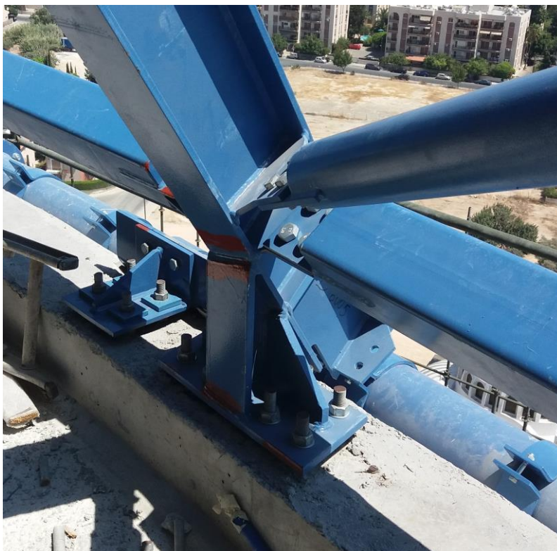
Εικόνα 7-11: Στήριξη τόξου
