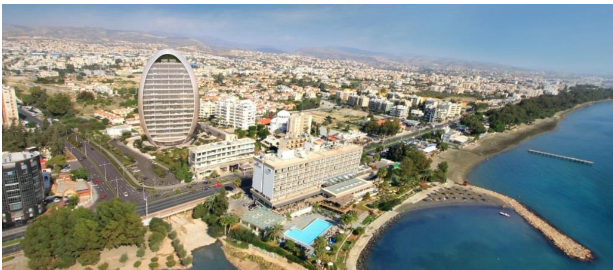
Εικόνα 1-1: Το κτίριο “The Oval” και οι τριγύρω περιοχές
