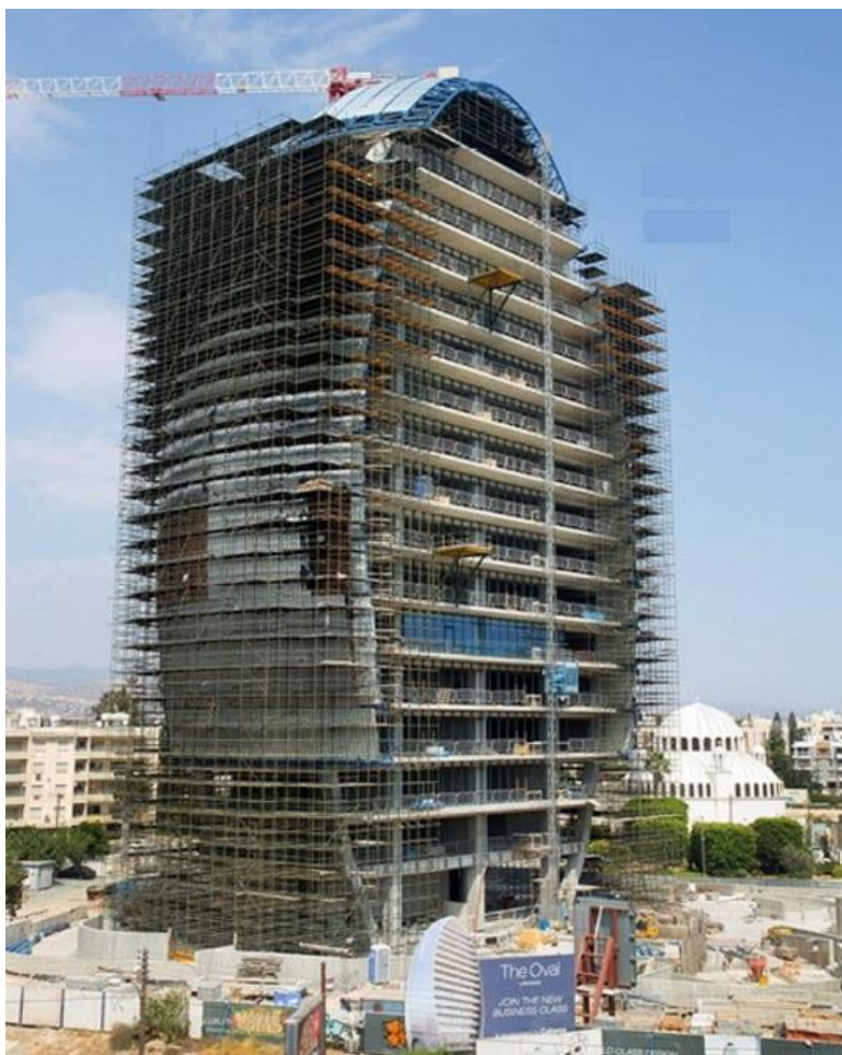
Εικόνα 1-7: Πρόοδος ολοκλήρωσης του έργου, Σεπτέμβριος 2016
