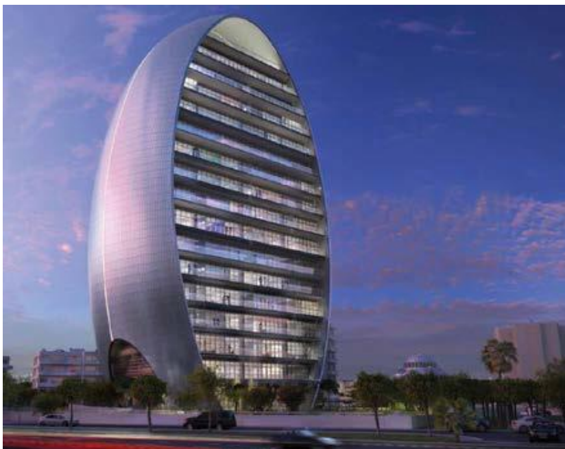
Εικόνα 1-3: Πλάγια όψη κτιρίου με άνοιγμα στη πλευρά του κτιρίου
