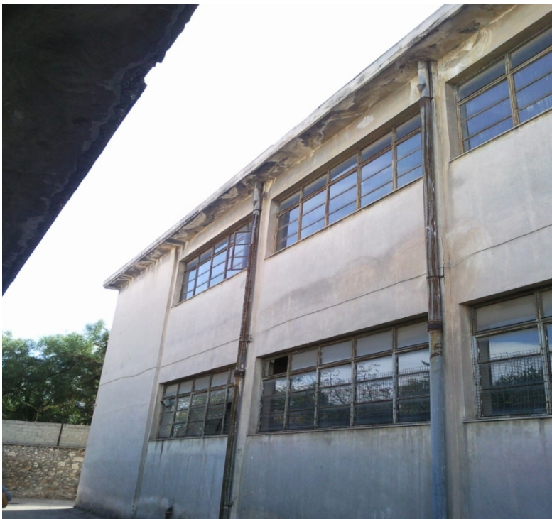
Εικόνα 1.1: Δυτική όψη κτηρίου
