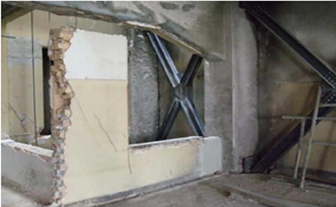
Εικόνα 4.15: Ενίσχυση κτηρίου με χιαστί συνδέσμους δυσκαμψίας
