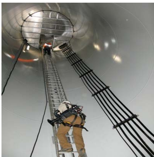
Σχήμα 16 Εργαζόμενοι στο εσωτερικό της ανεμογεννήτριας
