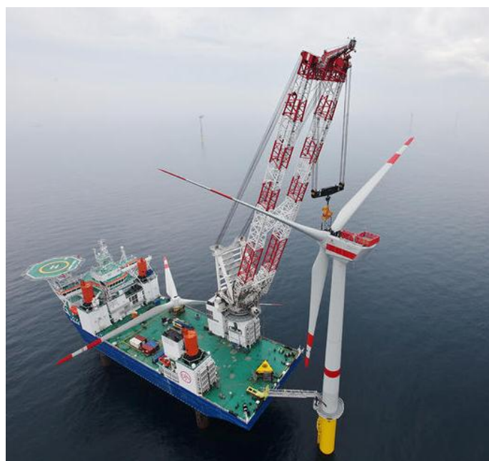
Σχήμα 21 Jack-up σκάφος το οποίο συμμετέχει στην συναρμολόγηση ανεμογεννήτριας
