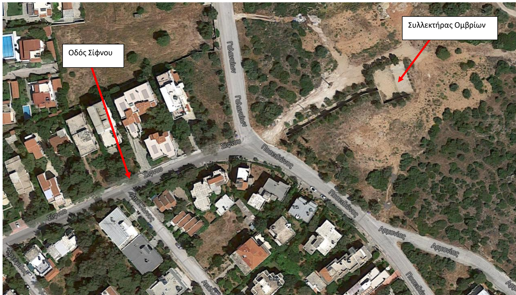
Εικόνα 2.2: Ο συλλεκτήρας ομβρίων υδάτων στην συνέχεια της οδού Σίφνου
