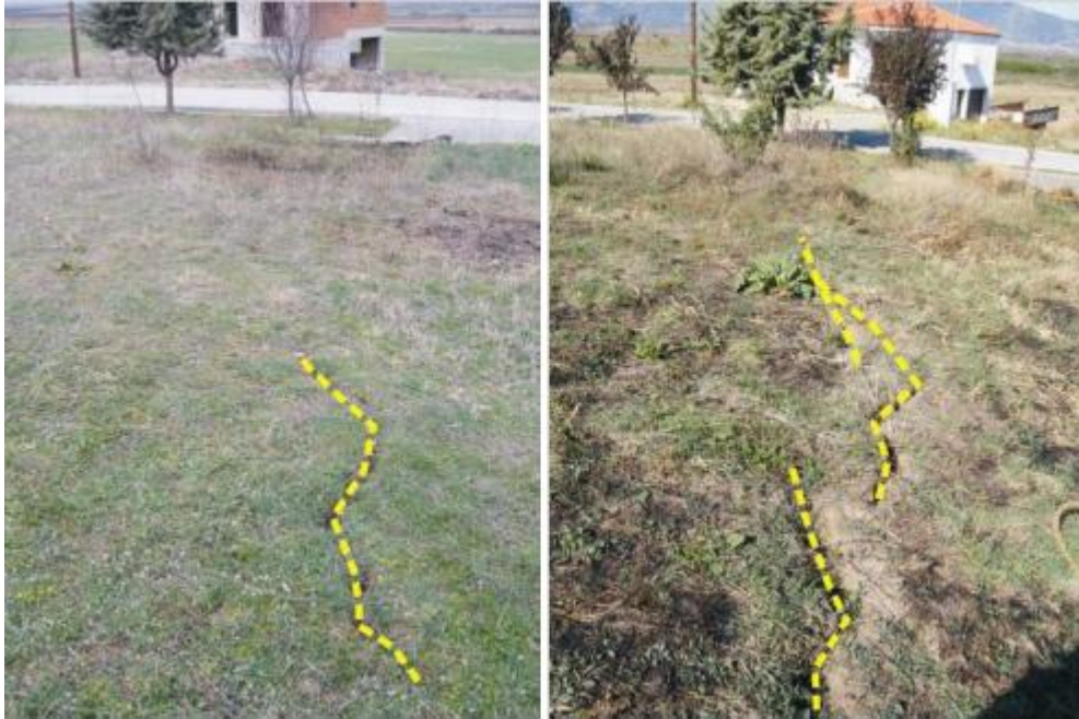
Εικόνα 2.2: Φωτογραφίες μεταβολής της εδαφικής διαρρήξεως στον οικισμό των Αναργύρων, σε χρονικό διάστημα 1,5 χρόνου. Το μέγιστο άλμα κατά μήκος της διάρρηξης είναι 15 - 20 cm. (Loupasakis, 2014).
