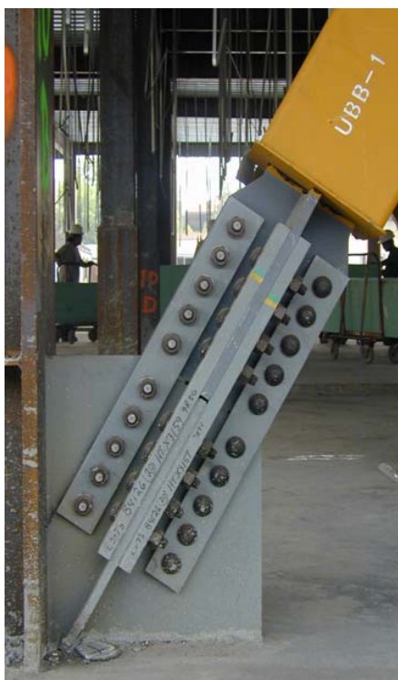
Σχήμα 1.14: Κοχλιωτή σύνδεση για συνδέσμους δυσκαμψίας BRB, βασισμένη στους Saif et al. (2005)
