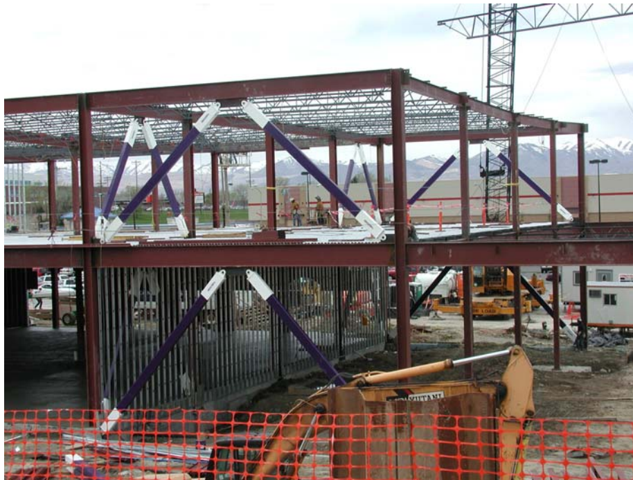
Σχήμα 1.10: Εφαρμογή στην πράξη των συνδέσμων δυσκαμψίας BRB, βασισμένη στον Engelhardt (2007)
