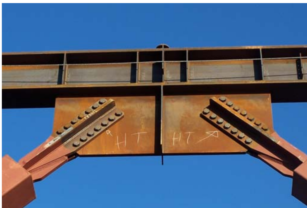
Σχήμα 1.15: Κοχλιωτή σύνδεση για συνδέσμους δυσκαμψίας BRB, βασισμένη στους Saif et al. (2005)
