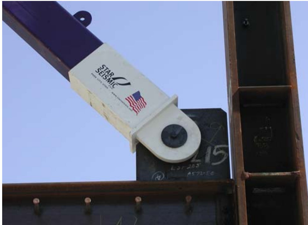
Σχήμα 1.16: Σύνδεση πραγματικής άρθρωσης για συνδέσμους δυσκαμψίας BRB, βασισμένη στους Saif et al. (2005)
