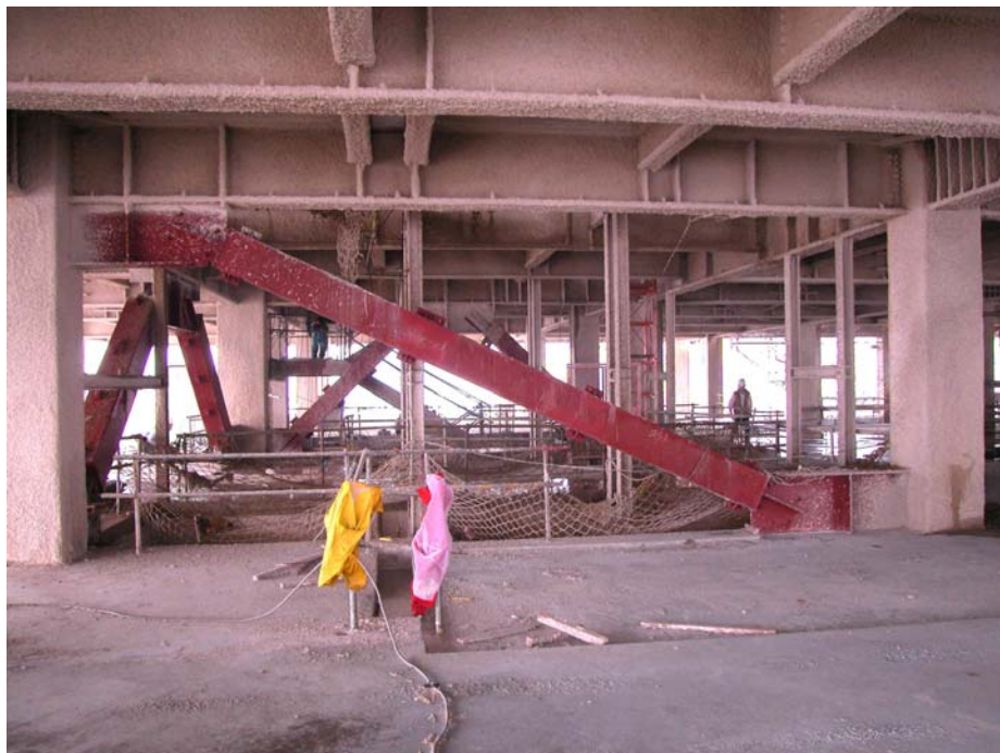
Σχήμα 1.12: Εφαρμογή στην πράξη των συνδέσμων δυσκαμψίας BRB, βασισμένη στον Engelhardt (2007)
