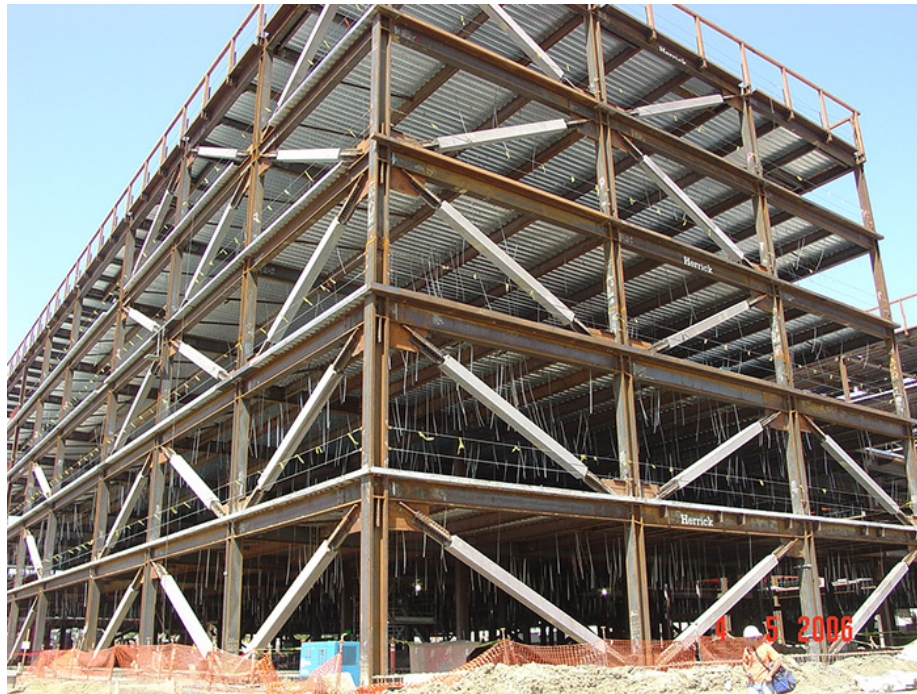
Σχήμα 1.11: Εφαρμογή στην πράξη των συνδέσμων δυσκαμψίας BRB, βασισμένη στον Engelhardt (2007)
