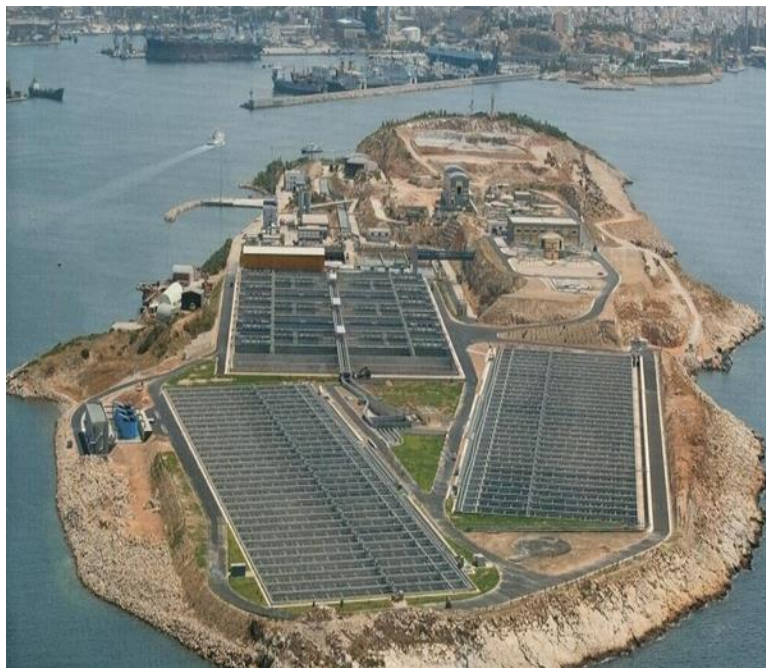
Εικόνα 3-1: Αεροφωτογραφία Κέντρου Επεξεργασίας Λυμάτων Ψυττάλειας
