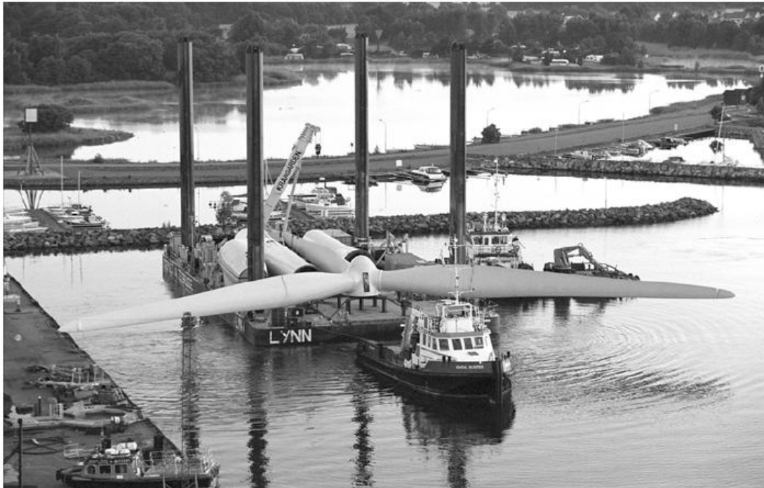
Εικόνα 6: Μεταφορά αποσυναρμολογημένου στροφέα (διαμέτρου 70 μέτρων) για τοποθέτηση στο υπεράκτιο αιολικό πάρκο “Yttre Stengrund” στη Σουηδία
