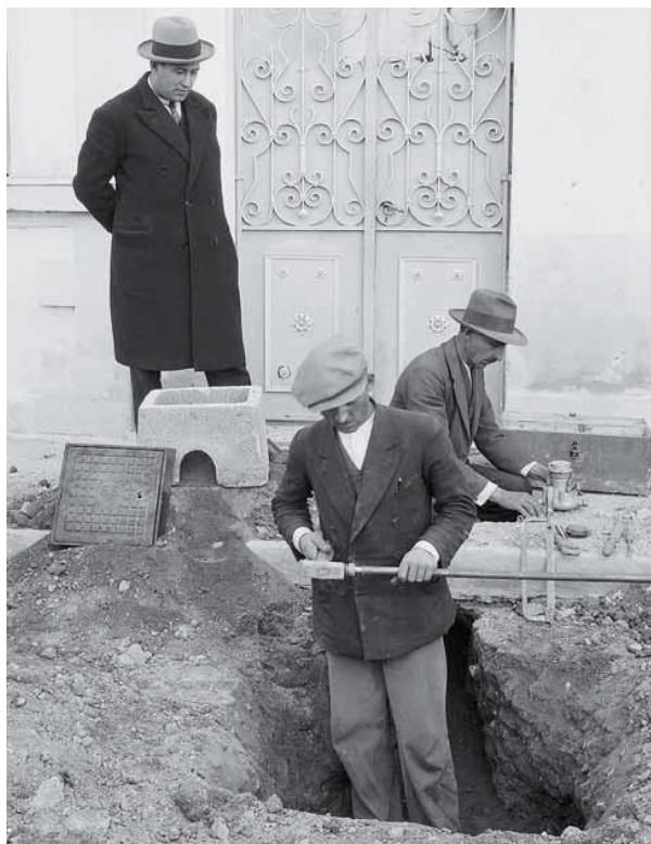
Εικόνα 1.4: Τοποθέτηση Υδρομετρητών (ΕΥΔΑΠ 2013)
