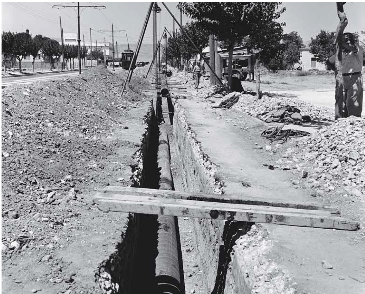
Εικόνα 1.3: Τοποθέτηση αγωγού εντός της πόλης των Αθηνών (ΕΥΔΑΠ 2013)
