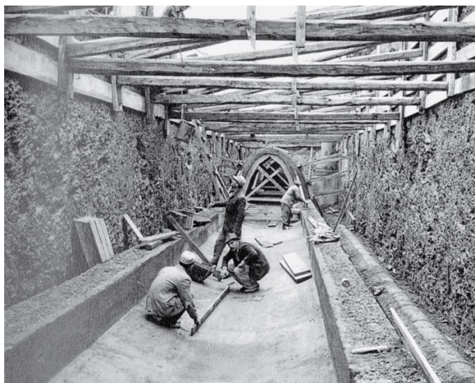
Εικόνα 1.1: Κατασκευή συλλεκτήρα ακαθάρτων (1939) (ΕΥΔΑΠ 2013)
