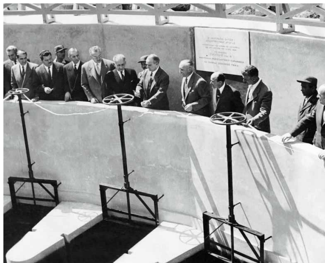
Εικόνα 1.5: Εγκαίνια Κεντρικού Αποχετευτικού Αγωγού (ΕΥΔΑΠ 2013)
