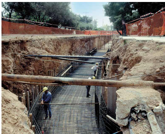
Εικόνα 1.6: Κατασκευή αποχετευτικού αγωγού στην Αθήνα (2000) (ΕΥΔΑΠ 2013)
