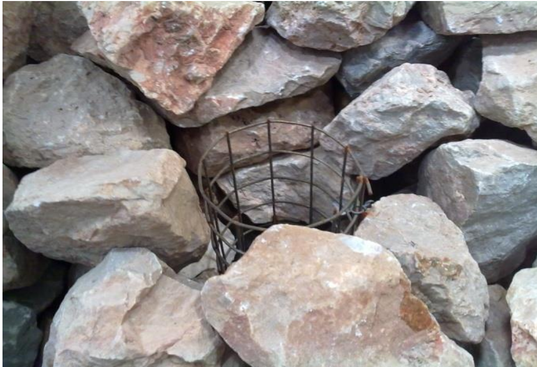
Εικόνα 5.7 Προστατευτικό κυλινδρικό πλέγμα στις διατομές μέτρησης.
