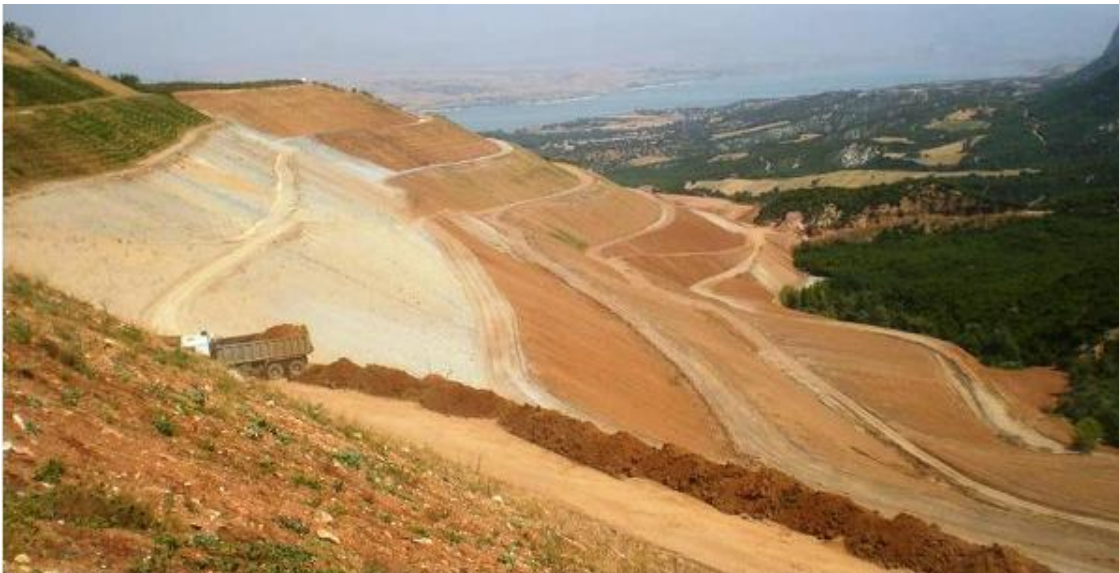
Εικόνα 27: Μεταφορά και διάστρωση φυτικής γης.
