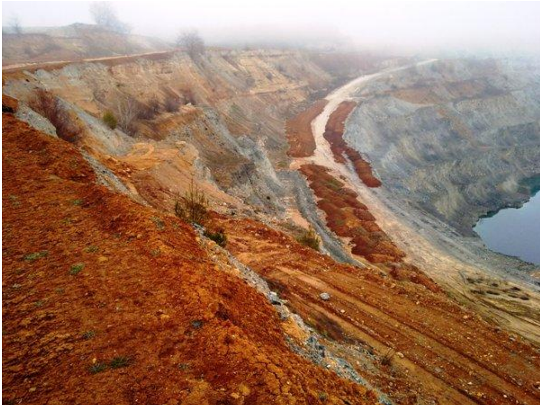
Εικόνα 25: Διάστρωση φυτικής γης στο μεταλλείο.
