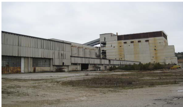
Εικόνα 12: Γενική άποψη των κτιριακών εγκαταστάσεων.
