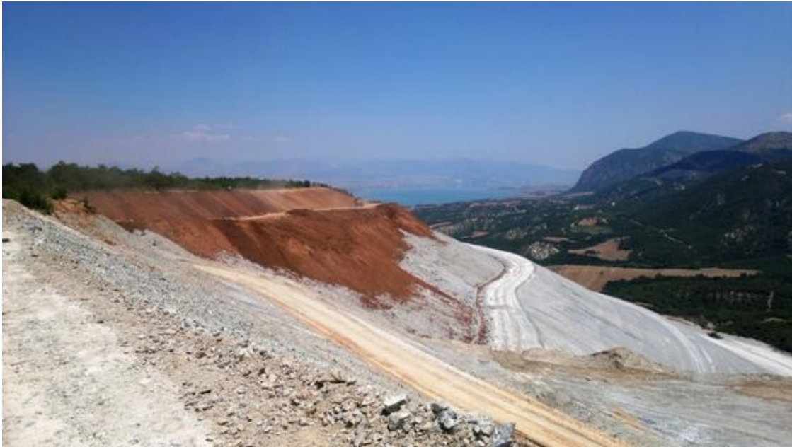
Εικόνα 26: Διάστρωση φυτικής γης.
