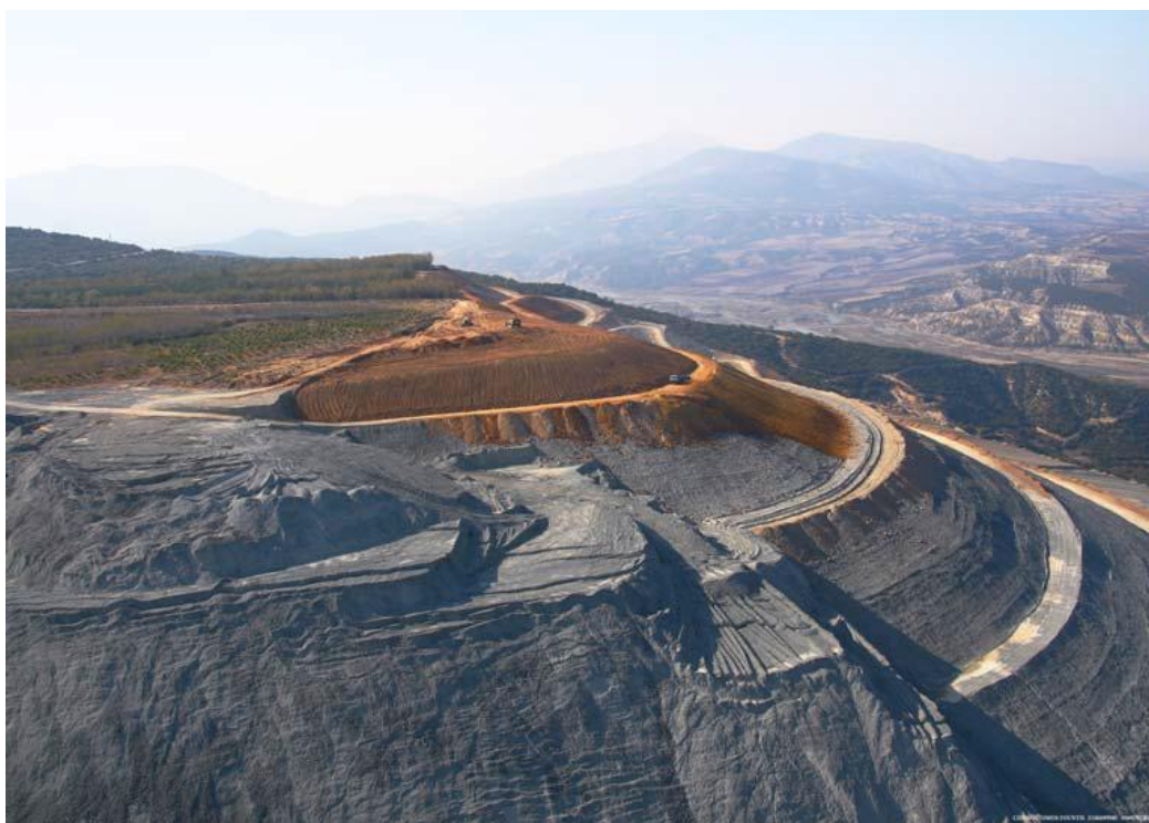
Εικόνα 20: Αποκατάσταση των αποθέσεων.
