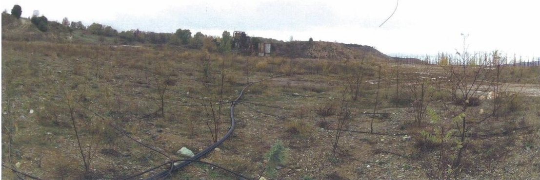
Εικόνα 33: Άποψη των οριζόντιων επιφανειών μετά την εγκατάσταση της βλάστησης.
