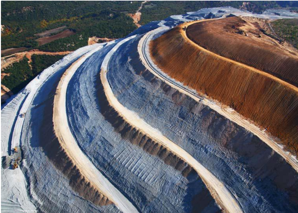
Εικόνα 21: Αποκατάσταση των αποθέσεων και κατασκευή βαθμίδων.
