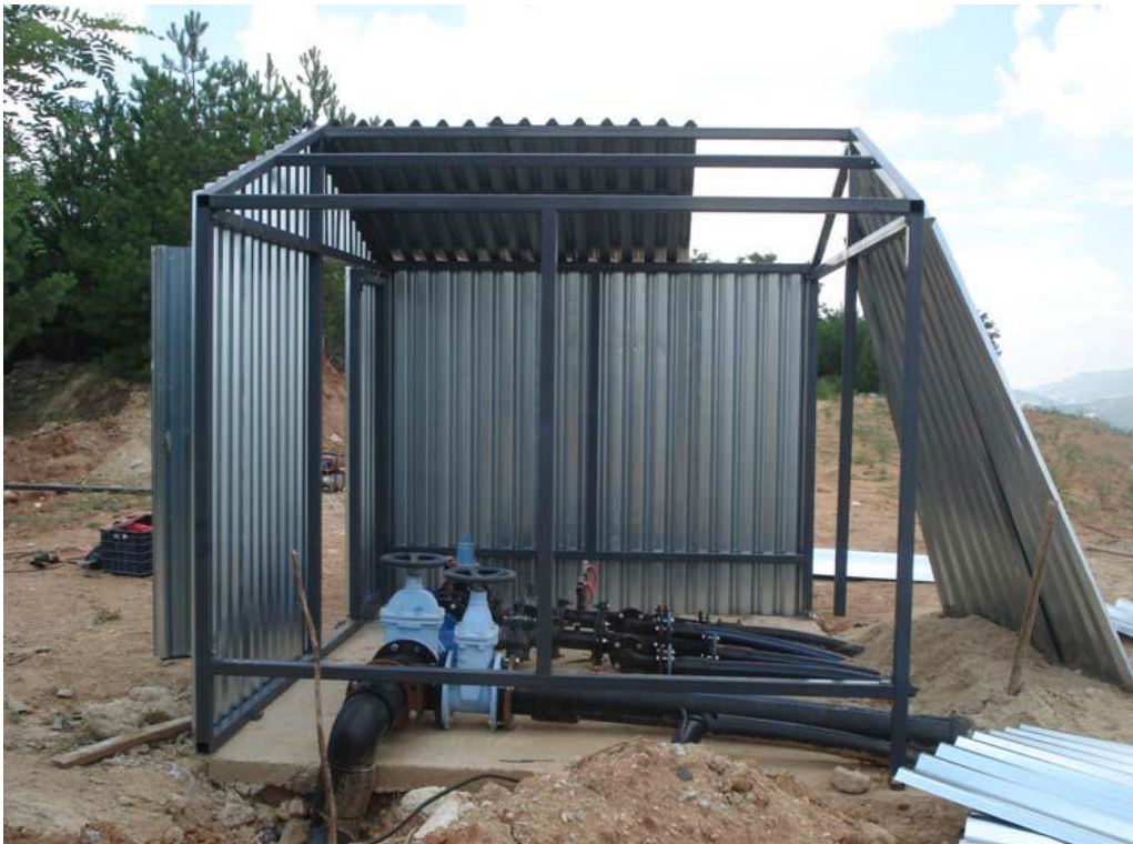
Εικόνα 28: Εγκατάσταση αρδευτικού δικτύου.
