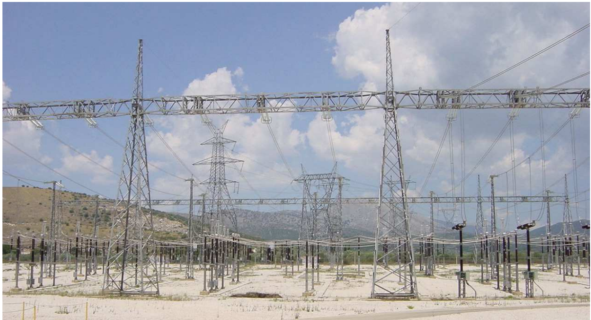
Φωτογραφία 2.2 - Διάταξη Ζυγών ΥΥΤ ΚΥΤ [12]
