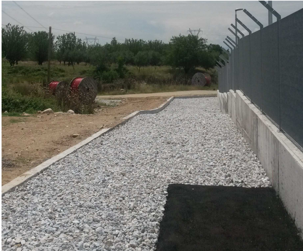
Φωτογραφία 6.5 - Τοποθέτηση χαλικιού και ασφάλτου εξωτερικά της περίφραξης του Υποσταθμού για την εξάλειψη των επικίνδυνων βηματικών τάσεων και τάσεων επαφής.
