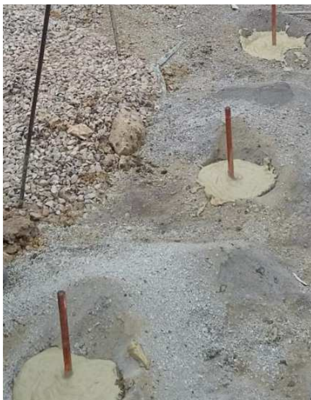
Φωτογραφία 6.1 - Τοποθέτηση ράβδων γείωσης στην περίφραξη του Υποσταθμού για την βελτίωση των επικίνδυνων Βηματικών Τάσεων ή Τάσεων Επαφής
