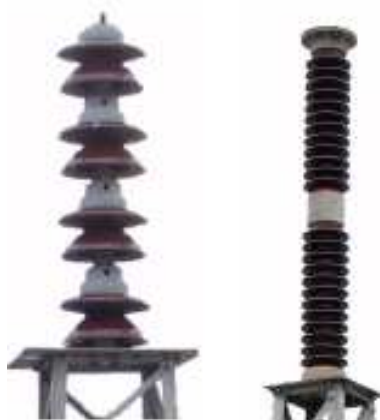
Φωτογραφία 2.9 - Μονωτήρες στηρίξεως 150 kV [12]
