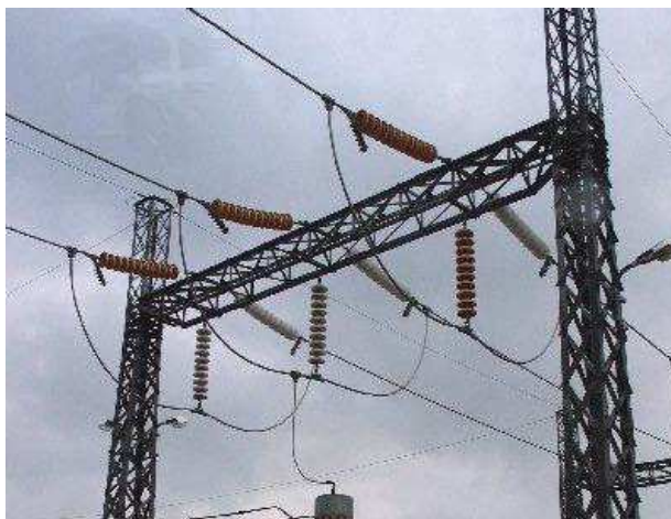
Φωτογραφία 2.8 - Ανάρτηση εναερίων ζυγών [12]
