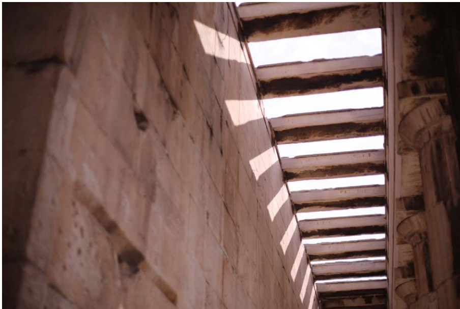
Απόπλυση της μαύρης κρούστας που έχει σχηματιστεί πάνω από την πορτοκαλί επιδερμίδα στην μερικώς προστατευμένη από τη ροή του νερού κάτω επιφάνεια των μαρμάρινων δοκών του νότου πτερού. Η επιδερμίδα εμφανίζεται σταδιακά προς τις αποπλυμένες περιοχές.
