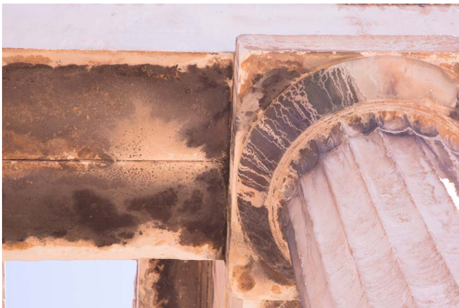
Εκτεταμένη περιοχή μαύρης κρούστας στη νοτιοδυτική γωνία του ναού, με διάφορους βαθμούς έκπλυσης.
