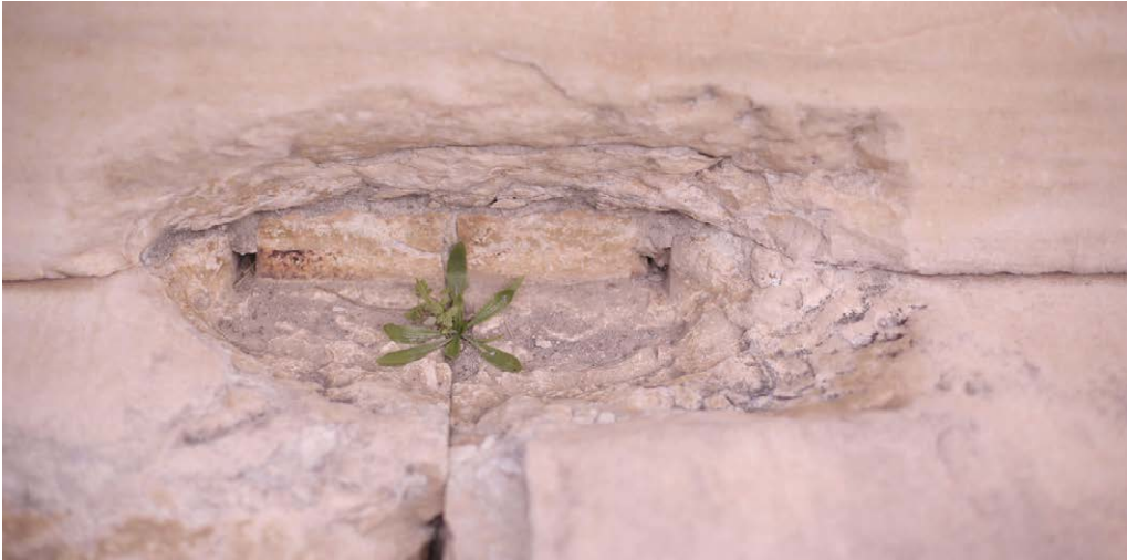
αποσκαμμένος σύνδεσμος στην κρητίδα. διακρίνεται γέμισμα με οπτόπλινθο
