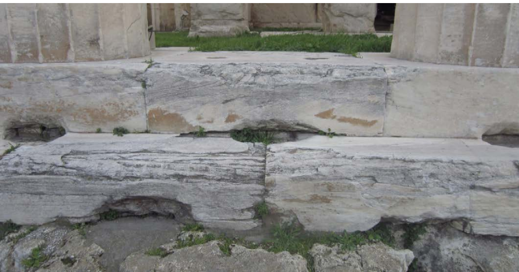
αποσκαμμένος σύνδεσμος στην κρητίδα. διακρίνεται γέμισμα με οπτόπλινθο
