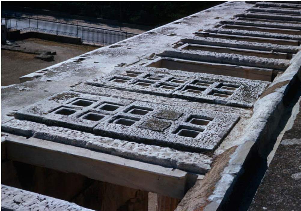
Οροφή νότιου πτερού. 1953
