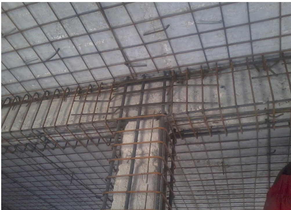
Εικόνα 37 - Προεργασία ενίσχυσης κτιρίου με Gunitite
