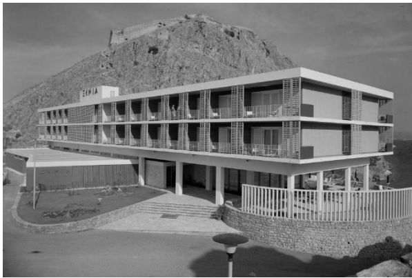
Εικόνα 6 - 1961 Βόρεια όψη ξενοδοχείου
