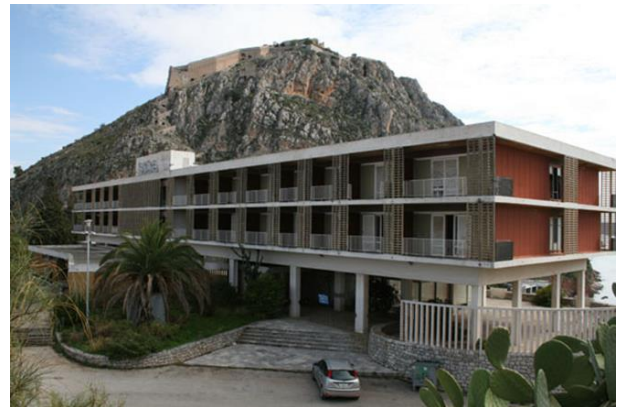
Εικόνα 3.2 - 2016 Βόρεια όψη ξενοδοχείου
