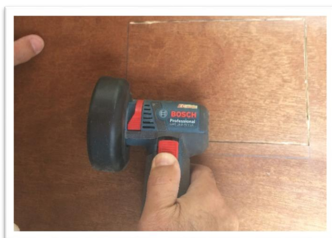
Σχέδιο 71 : Αρχική κοπή με μικρό τροχό
