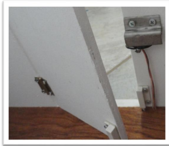
Σχέδιο 81 Τοποθέτηση H/M εμβόλου με την βάση στήριξης
