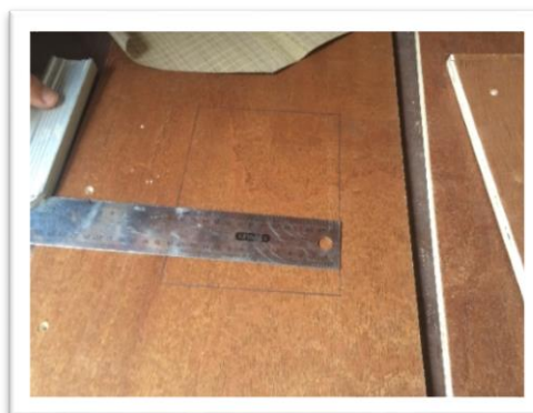
Σχέδιο 70: Μέτρηση πριν την κοπή πόρτας
