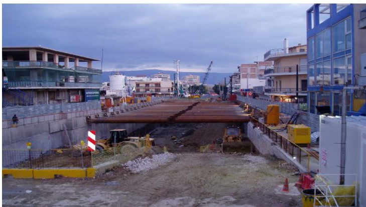
Εικόνα 1-6: Χρησιμοποίηση μεταλλικών αντηρίδων προς αποφυγή προβλημάτων με τα όμορα κτίσματα και τα δίκτυα Ο.Κ.Ω. – Σταθμός Ανθούπολης (1)
