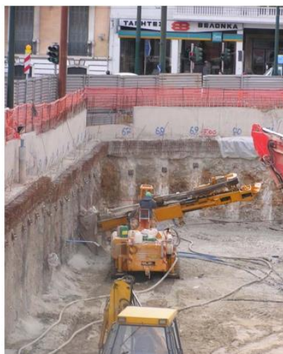
Εικόνα 1-3: Διάτρηση αγκυριών σε φρεατοπασσάλους
