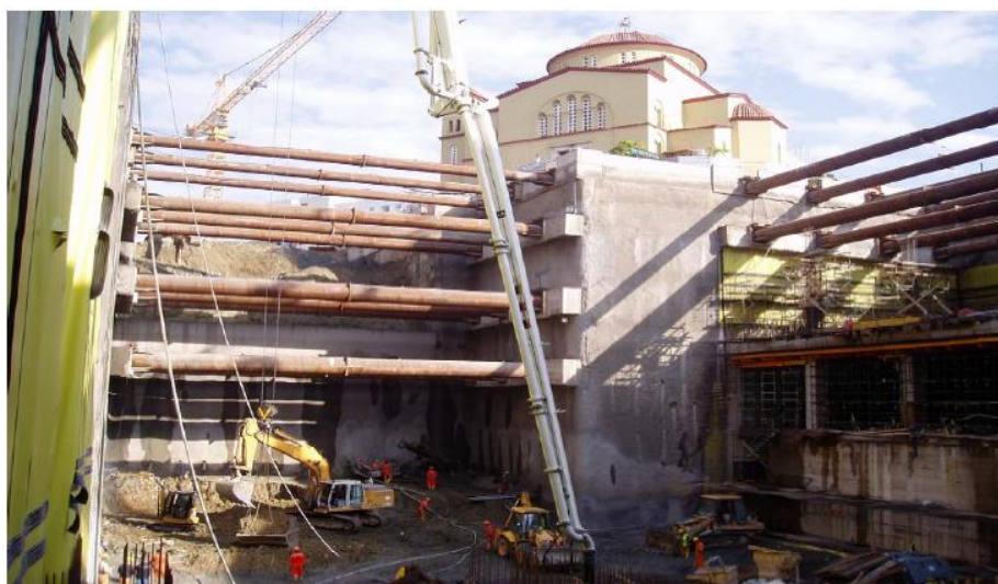
Εικόνα 1-9: Αντιστήριξη με μεταλλικές αντηρίδες προς αποφυγή αγκυρώσεων που "διασταυρώνονται" – Σταθμός Μετρό Περιστερίου
