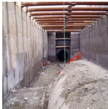
Εικόνα 1-7: Χρησιμοποίηση μεταλλικών αντηρίδων προς αποφυγή προβλημάτων με τα όμορα κτίσματα και τα δίκτυα Ο.Κ.Ω. – Σταθμός Μετρό Ανθούπολης (2)
