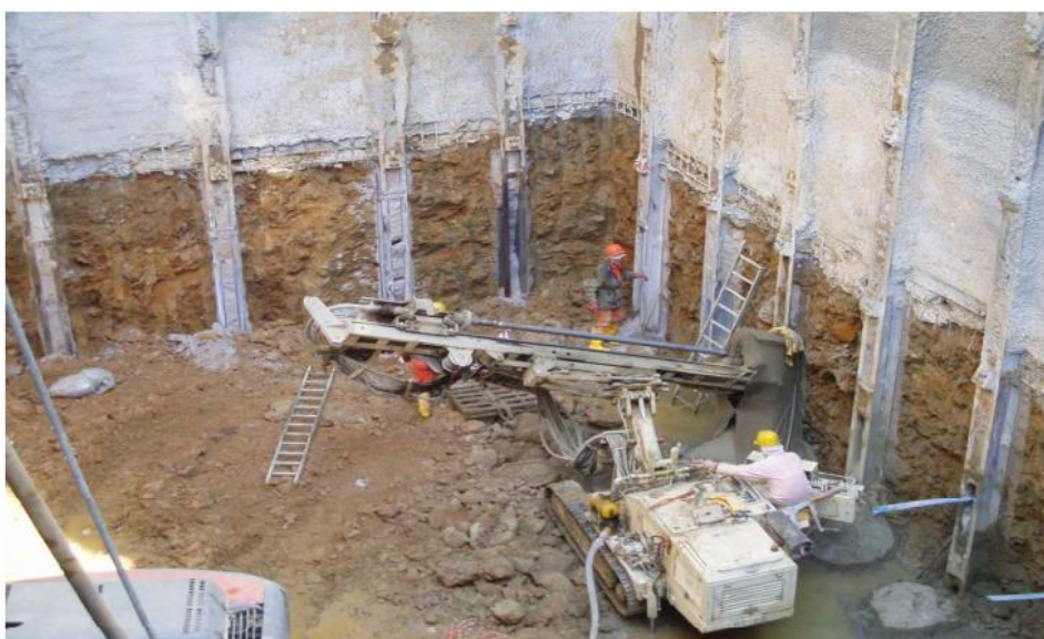
Εικόνα 1-4: Διάτρηση αγκυριών σε μεταλλικούς πασσάλους
