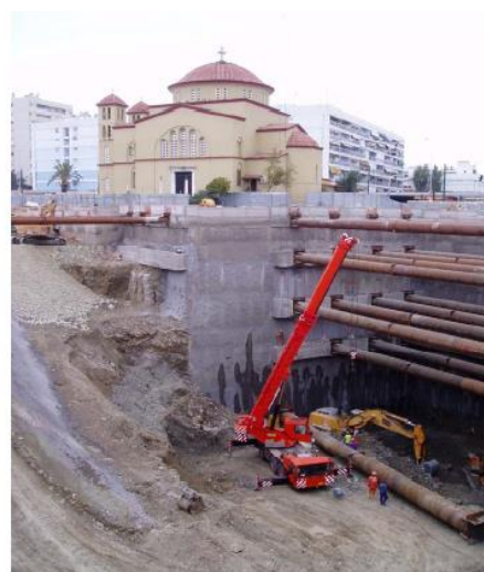
Εικόνα 1-8: Αντιστήριξη με μεταλλικές αντηρίδες – Σταθμός Μετρό Περιστερίου
