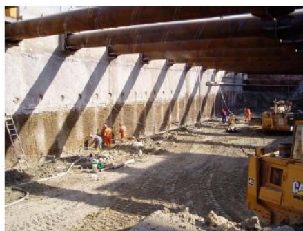
Εικόνα 1-7: Χρησιμοποίηση μεταλλικών αντηρίδων προς αποφυγή προβλημάτων με τα όμορα κτίσματα και τα δίκτυα Ο.Κ.Ω. – Σταθμός Μετρό Ανθούπολης (2)
