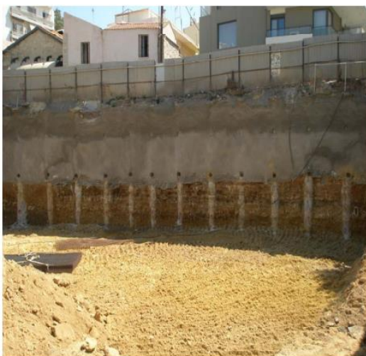
Εικόνα 1-3: Διάτρηση αγκυριών σε φρεατοπασσάλους
