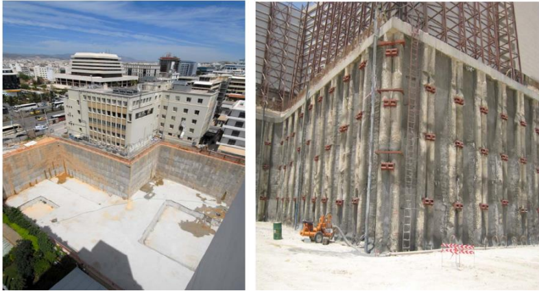
Εικόνα 1-5: Αντιστήριξη με αγκυρώσεις που διασταυρώνονται
