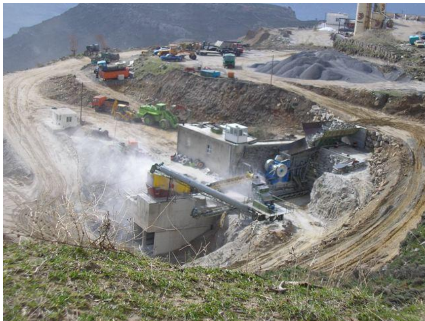
Εικόνα 3: Άποψη του ΧΑΔΑ
