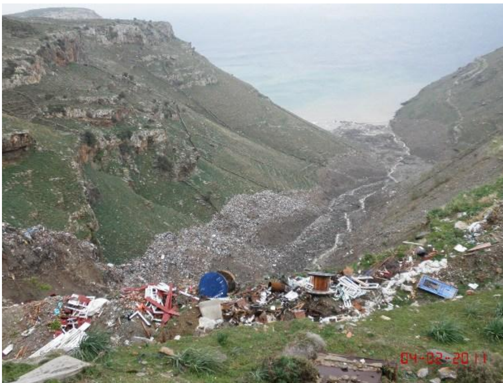
Εικόνα 8: Άλλη άποψη της κατολίσθηση απορριμμάτων ύστερα από έντονες βροχοπτώσεις τον Φεβρουάριο του 2011
