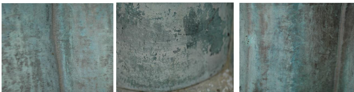
Εικόνα 99 : Πράσινες κηλίδες και επικαθίσεις-προϊόντα διάβρωσης
