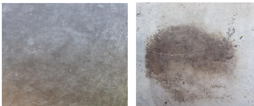
Εικόνα 239: Υπόλευκες επικαθήσεις-προϊόντα διάβρωσης πάνω σε καφέ μαύρες περιοχές
