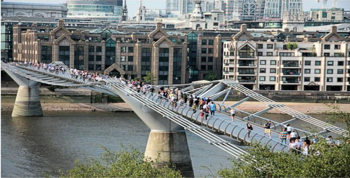
Σχήμα 8.1: Άποψη της πεζογέφυρας Millenium Bridge στο Λονδίνο, στην οποία εμφανίστηκαν έντονα δυναμικά φαινόμενα λόγω της κίνησης των πεζών.
