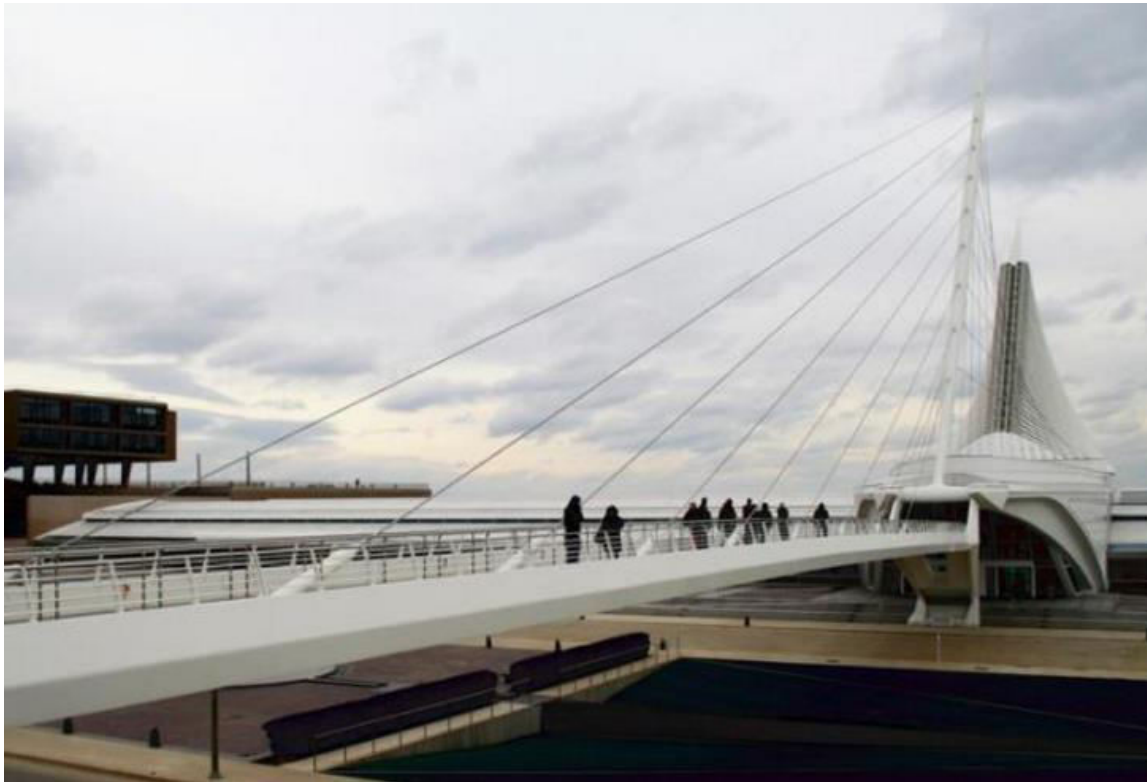
Σχήμα 1.1 Άποψη της πεζογέφυρας Reiman Bridge στις ΗΠΑ
