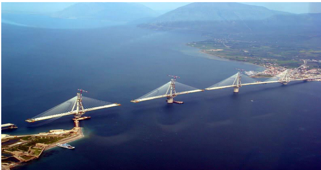
Σχήμα 5.3: Στάδιο προβολοδόμησης στη γέφυρα Ρίου-Αντιρρίου
