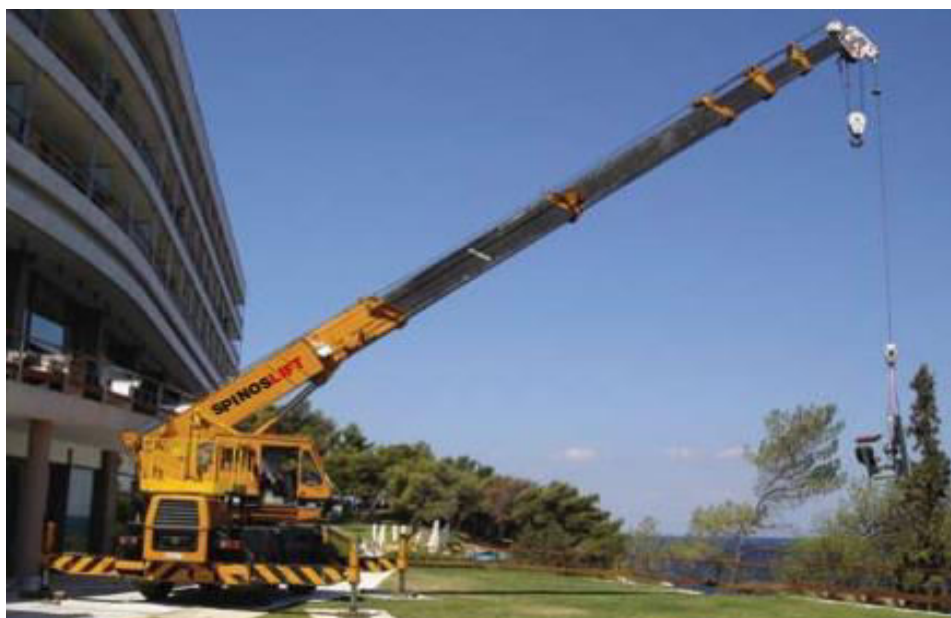
Σχήμα 6.10 Τηλεσκοπικός γερανός που θα χρησιμοποιηθεί για την ανέγερση
