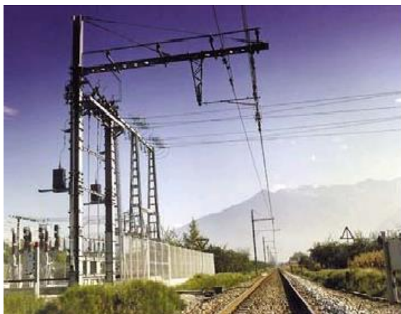
Εικόνα 11: Στοιχεία συστήματος ηλεκτροκίνησης (υποσταθμός έλξης - εναέρια γραμμή και «τρίτη σιδηροτροχιά»)[31]
