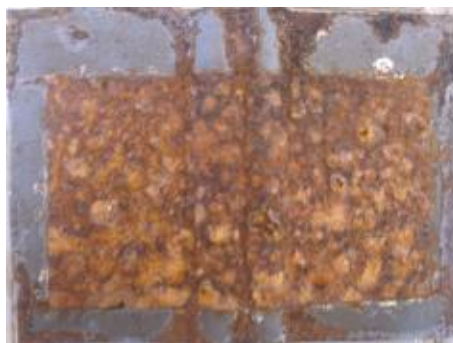
Εικόνα 5.44 β): Διαβρωμένη επιφάνεια δοκιμίου IIB1 μετά την έξοδό του από τον θάλαμο αλατονέφωσης
