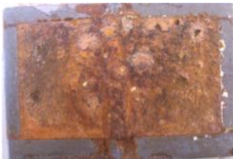
Εικόνα 5.34 β): Διαβρωμένη επιφάνεια δοκιμίου ΙΑ3 μετά την έξοδό του από τον θάλαμο αλατονέφωσης
