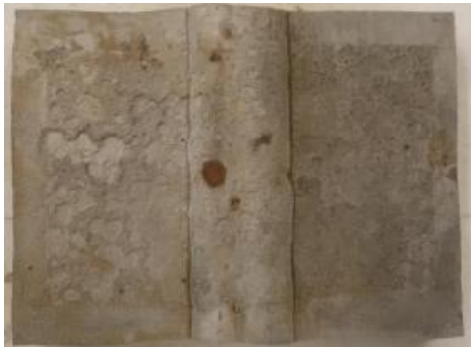
Εικόνα 5.46 γ): Δοκίμιο IIB3 μετά την απομάκρυνση των προϊόντων διάβρωσης
