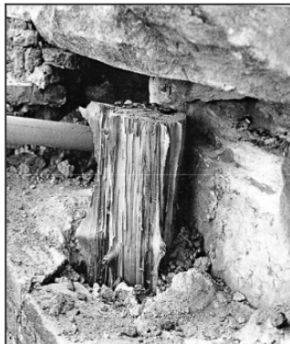
Εικόνα 2.2 Κορμός δέντρου που χρησιμοποιήθηκε από τον Πιττάκη στη στερέωση εσωτερικά των ορθοστατών τοίχου στο Ερέχθειο (11).
