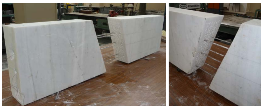
Εικόνα 10.9 Θραύσματα λίγο πριν τη συγκόλληση. Τράχυνση των επιφανειών συγκόλλησης.
