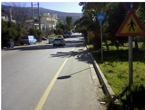
Εικόνα 12: Ποδηλατόδρομος επί της οδού Νευροκοπίου, δήμος Παπάγου
