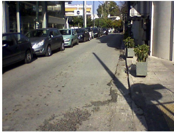
Εικόνα 14: Οδός Αφροδίτης, δήμος Χαλανδρίου
