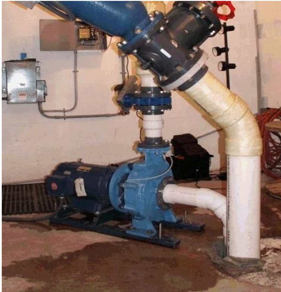
Σχήμα 1.25 Τυπική διάταξη μικρής αναστρέψιμης φυγοκεντρικής αντλίας συζευγμένη με γεννήτρια.
