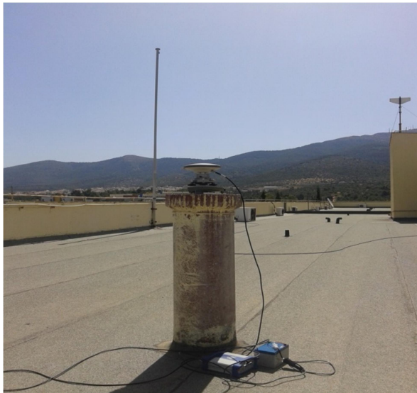
Εικόνα 4: Κεραία και δέκτης GPS στο βάθρο της ταράτσας στο κτήριο Λαμπαδάριο
