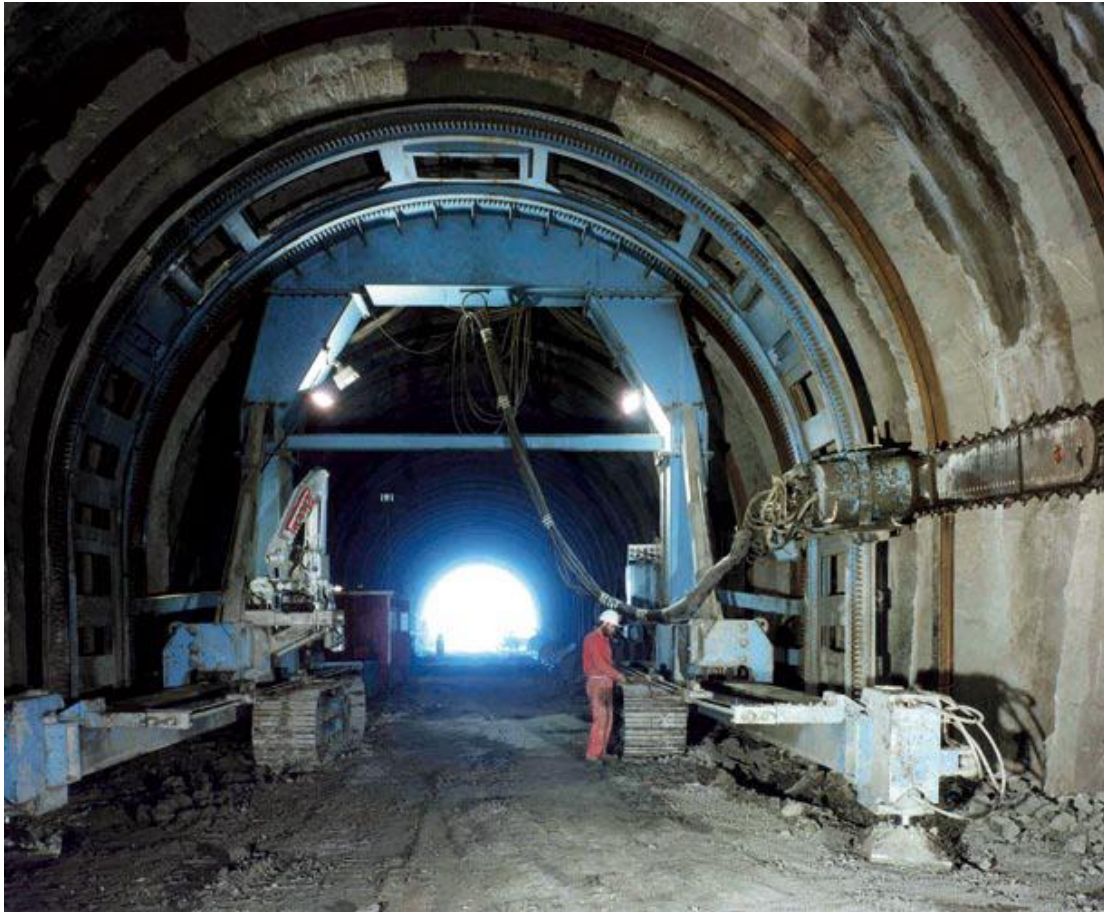
Εικόνα 5.8: Ολομέτωπη κοπή της σιδηροδρομικής γραμμής από την μηχανή πρότμησης (Sibari-Cosenza, 1985, έδαφος: άργιλος και λάσπη, μέγιστο ύψος υπερκειμένων: 110m) (Pietro Lunardi, 2008)
