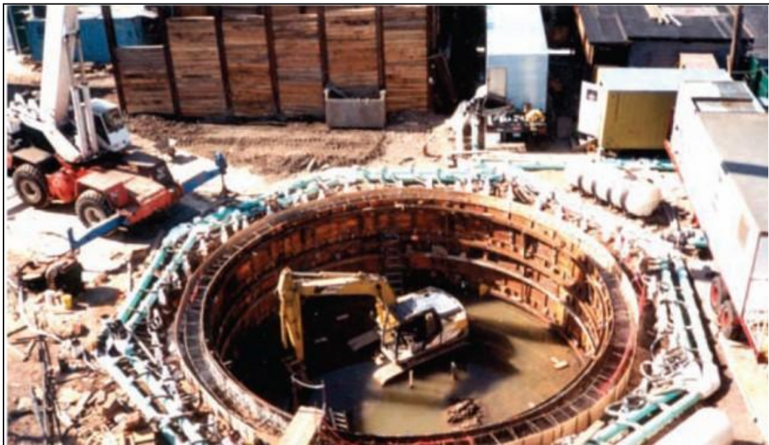
Εικόνα 5.4: Σύστημα σωληνώσεων ψύξης από εκσκαφή για την σταθεροποίηση του εδάφους (Ιατράκης, 2011)
