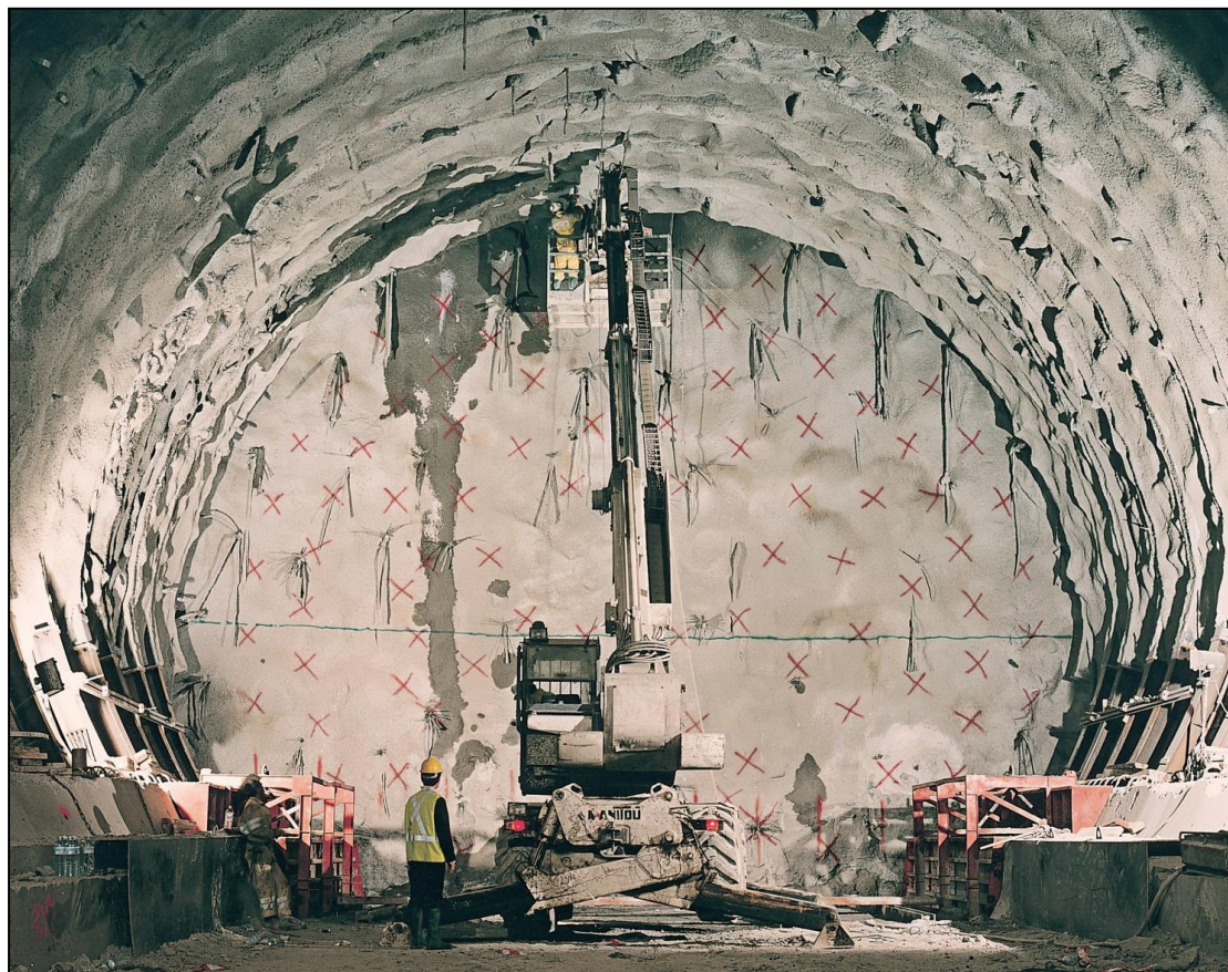
Εικόνα 5.2:Νέος γύρος τοποθέτησης ύλων μετώπου από υαλονήματα (Σοφιανός, 2015)
