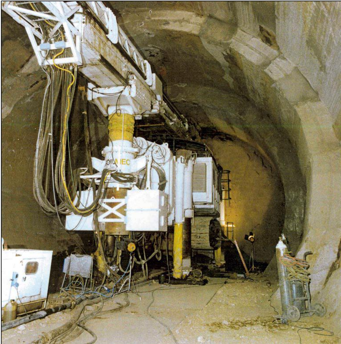
Εικόνα 5.17: Το μηχάνημα Pretunnel σε λειτουργία (υψηλής ταχύτητας / υψηλής χωρητικότητας σιδηροδρομική γραμμή Ρώμη-Νάπολη, Castello 1 σήραγγα, 1996, έδαφος: ηφαιστειακή τέφρα, μέγιστο ύψος υπερκείμενων: 9 m) (Pietro Lunardi, 2008)
