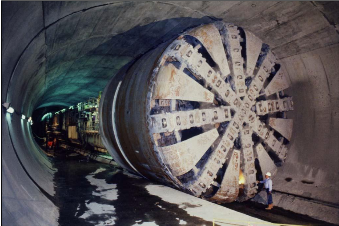
Εικόνα 3.12: Μηχάνημα Ολομέτωπης Κοπής με ασπίδα ( www.ametro.gr )
