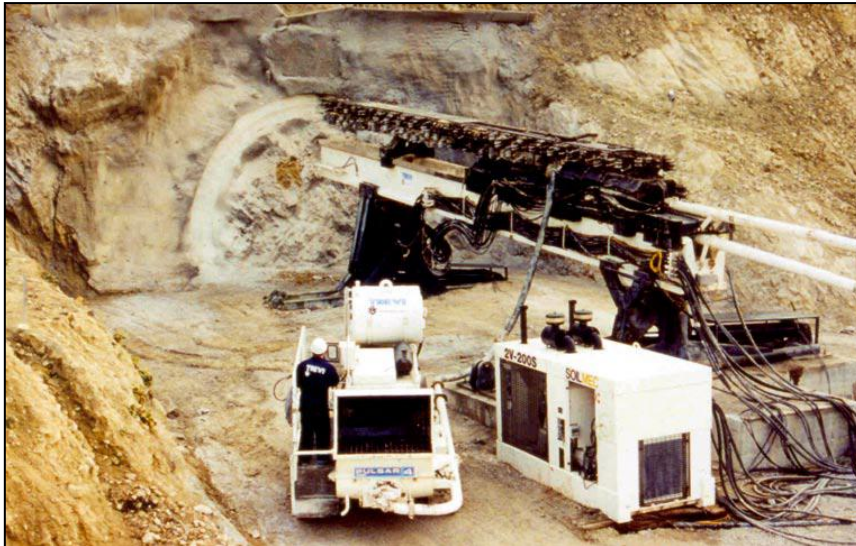
Εικόνα 5.14: Περιοχή δοκιμής pretunnel (1996) (Pietro Lunardi, 2008)
