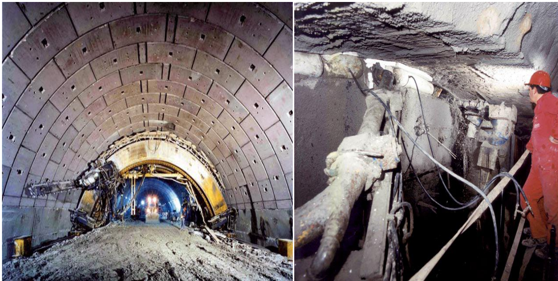
Εικόνα 5.12: Ολομέτωπη κοπή από την μηχανή πρότμησης (γραμμή Α του μετρό της Ρώμης, Baldo degli Σταθμός Ubaldi, 1996, έδαφος: πηλός με στρώματα άμμου, ύψος υπερκειμένων: ~ 18 m) (Pietro Lunardi, 2008)
