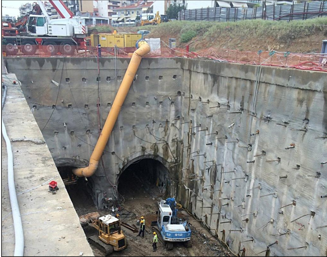
Εικόνα 1.2: Μετρό Θεσσαλονίκης, επέκταση γραμμής Καλαμαριάς (Σοφιανός, 2015)
