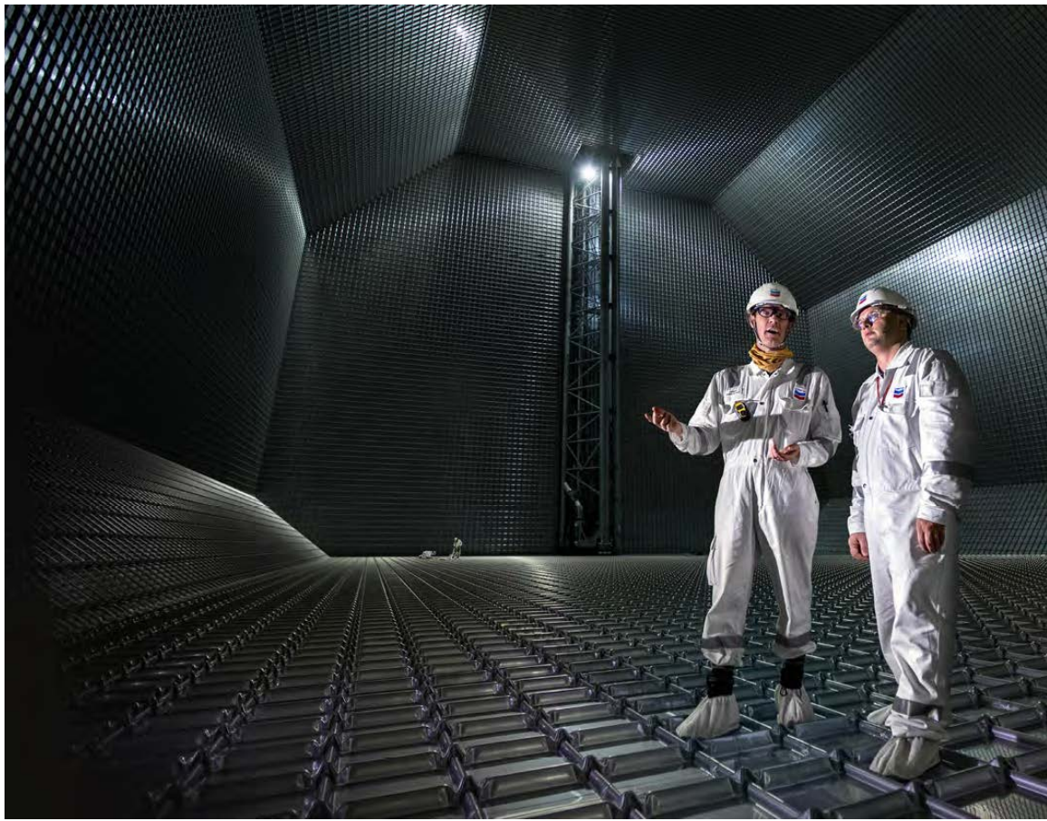
Figure 25 LNG carrier tank
