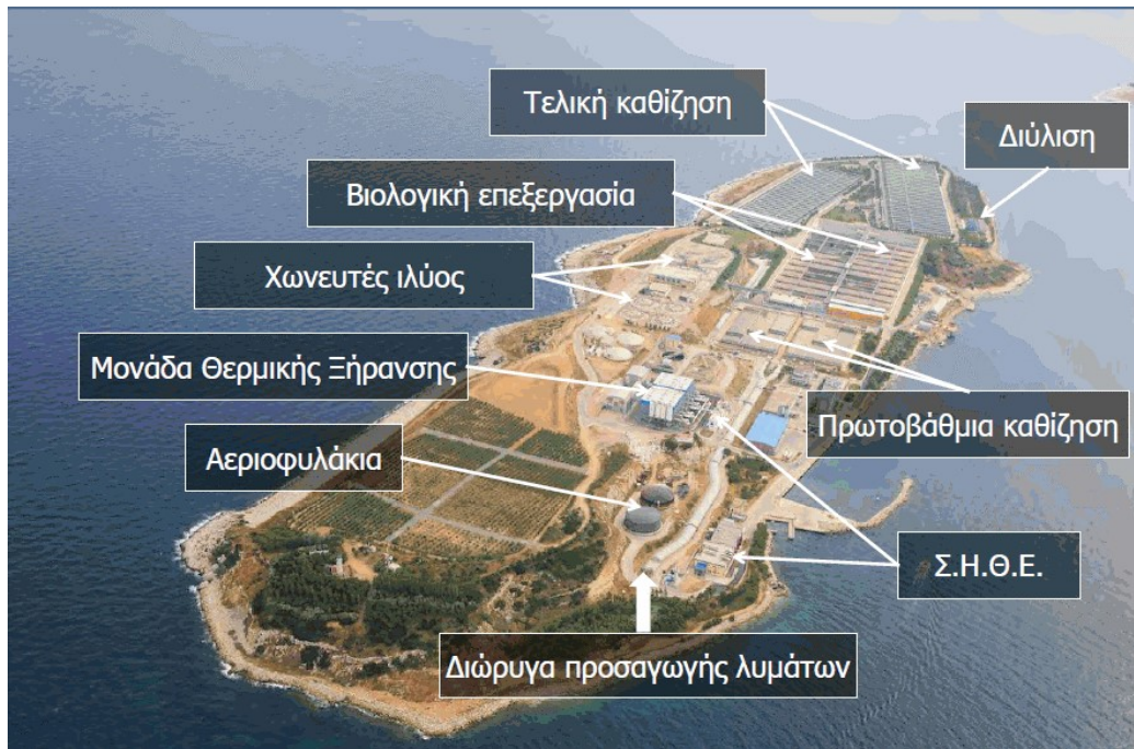
Εικόνα 3.2.3 : Εγκαταστάσεις επεξεργασίας Ψυττάλειας [87]
