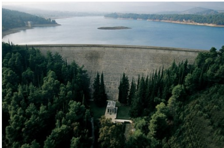
Εικόνα 2.6.1 : Φράγμα και λίμνη Μαραθώνα [20]
