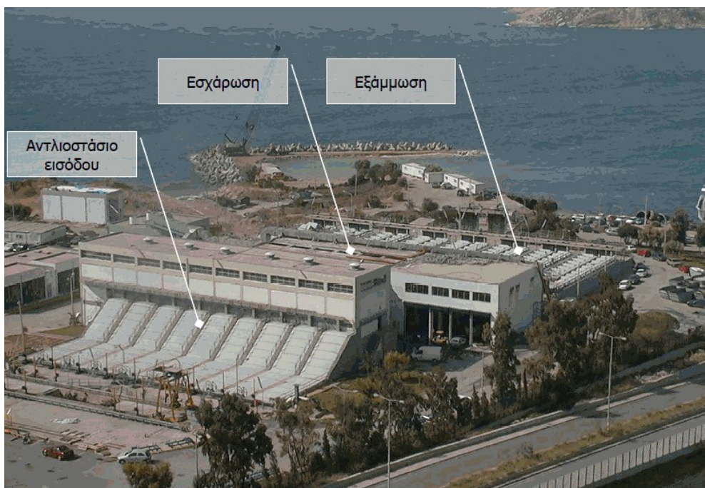
Εικόνα 3.2.2 : Εγκαταστάσεις προεπεξεργασίας Ακροκέραμου [87]
