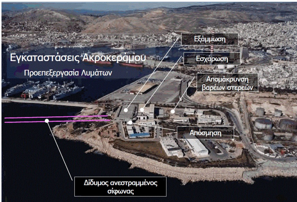
Εικόνα 3.2.1 : Εγκαταστάσεις προεπεξεργασίας Ακροκέραμου [87]
