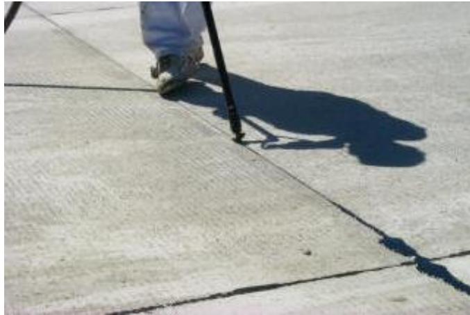
Εικόνα 4.7 Πλήρωση-σφράγιση αρμών διαστολής οδοστρώματος από σκυρόδεμα
