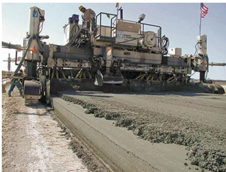
Εικόνα 3.9 Κατασκευαστική μέθοδος δύο επιπέδων
