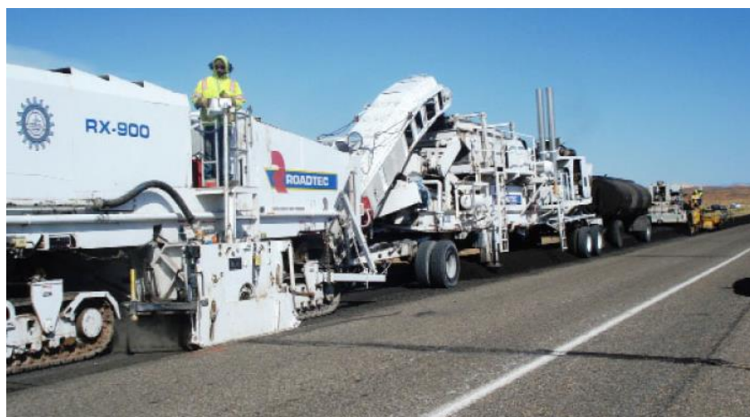
Εικόνα 4.12 Ψυχρή επί τόπου ανακύκλωση ασφαλτικού οδοστρώματος
