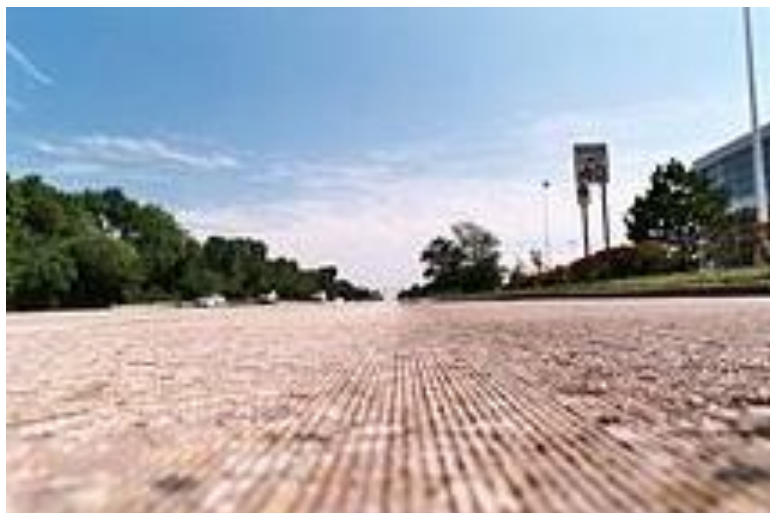
Εικόνα 4.10 Μόρφωση διαμήκους γράμμωσης/αυλάκωσης σε οδόστρωμα από σκυρόδεμα
