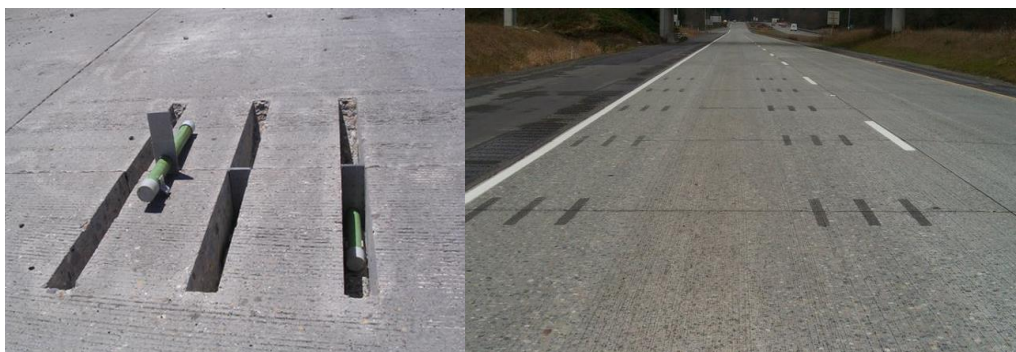
Εικόνα 4.8 Μηχανισμός βλήτρου αριστερά & τεχνική αντικατάστασης βλήτρων αρμών σε οδόστρωμα από σκυρόδεμα δεξιά
