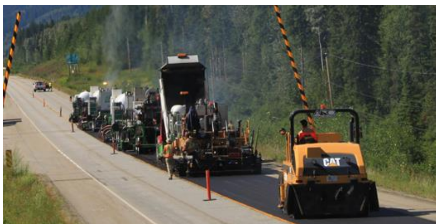
Εικόνα 4.11 Θερμή επί τόπου ανακύκλωση ασφαλτικού οδοστρώματος
