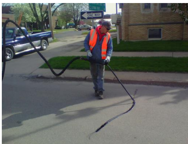
Εικόνα 4.2 Διαδικασία πλήρωσης-επισφράγισης επιφανειακών ρωγμών ασφαλτικών οδοστρωμάτων
