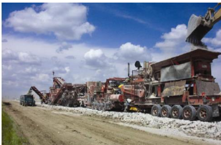
Εικόνα 4.13 Επί τόπου ανακύκλωση οδοστρώματος από σκυρόδεμα
