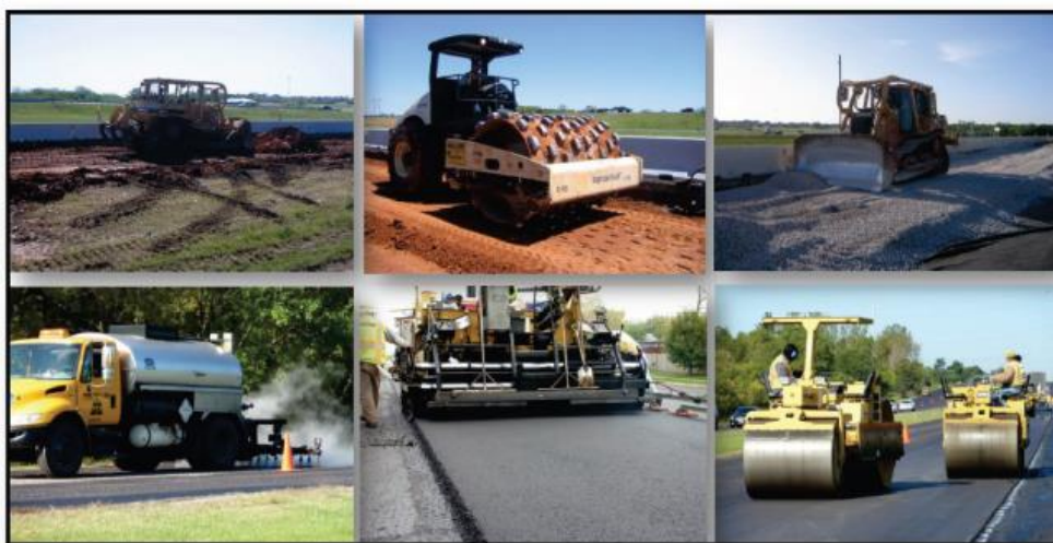
Εικόνα 3.7 Κατασκευαστική διαδικασία ασφαλτικών οδοστρωμάτων
