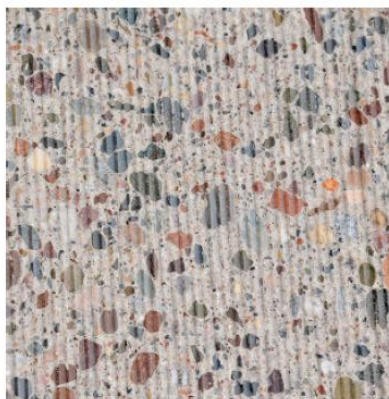
Εικόνα 3.6 Παράδειγμα έκθεσης των εκ σχεδιασμού ανοιχτόχρωμων αδρανών στην επιφάνεια συμβατικού οδοστρώματος από σκυρόδεμα
