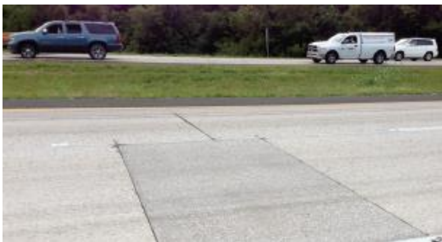
Εικόνα 4.9 Τοπική επιδιόρθωση οδοστρώματος από σκυρόδεμα
