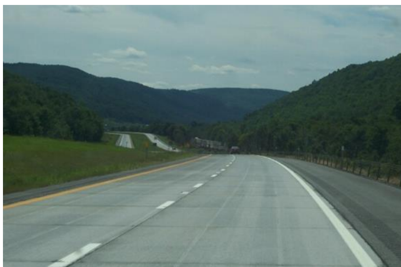
Εικόνα 4.6 Κατασκευή συνδεδεμένης επίστρωσης σκυροδέματος σε υπάρχον ασφαλτικό οδόστρωμα
