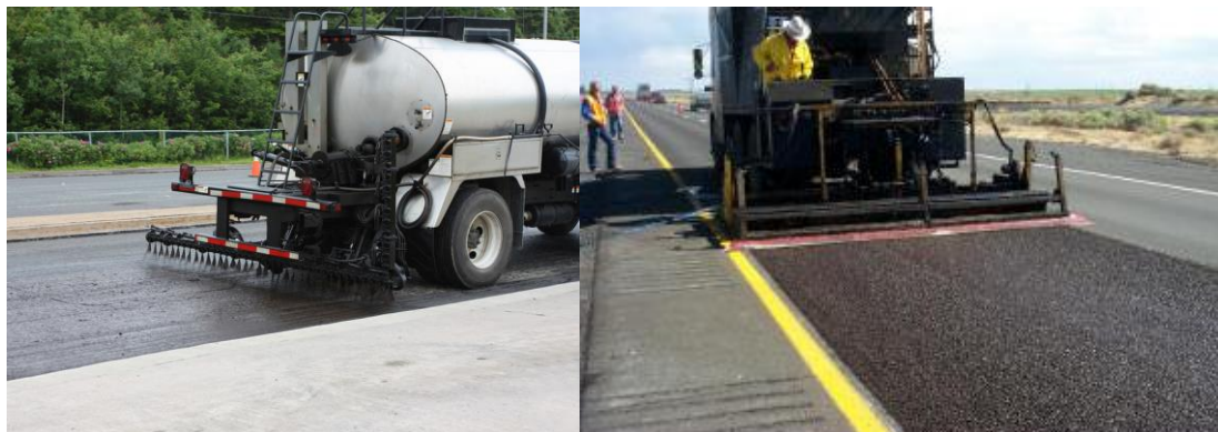
Εικόνα 4.4 Τεχνική συντήρησης με τη μορφή γαλακτώματος αριστερά (fog seal) & με την εμφανή παρουσία λεπτόκοκκων αδρανών δεξιά (slurry seal)
