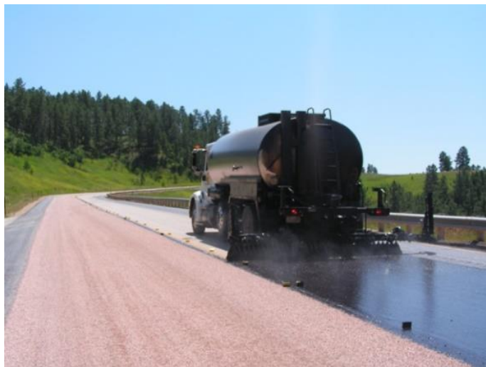
Εικόνα 2.10 Ασφαλτοϋδαρές επισφραγιστικό μείγμα (fog seal)
