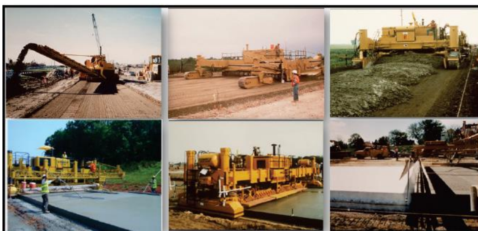
Εικόνα 3.8 Διαδικασία κατασκευής οδοστρωμάτων από σκυρόδεμα
