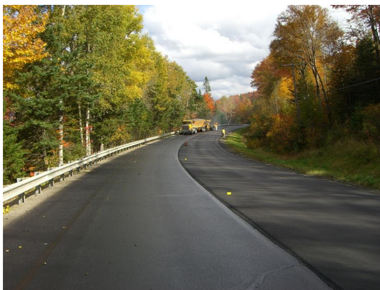
Εικόνα 4.5 Κατασκευή λεπτής ασφαλτικής επίστρωσης σε υφιστάμενο οδόστρωμα
