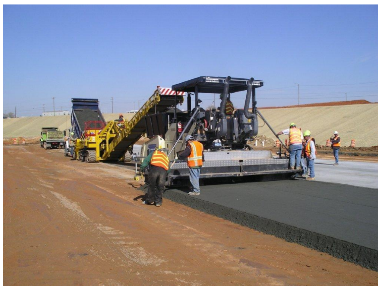
Εικόνα 3.10 Μέθοδος κυλινδρούμενου σκυροδέματος, RCC
