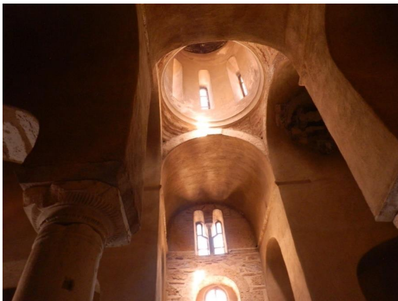
Εικόνα 1-3: Εσωτερικό της Μεταμόρφωσης του Σωτήρος Πλάκας. Τα δυο κύρια κλίτη που ορίζονται από τις ημικυλινδρικές καμάρες και τους πεσσούς έδρασής τους, σχηματίζουν τον εσωτερικό σταυρό. Στη μέση δεσπόζει ο τρούλος και στη βάση του τα 4 λοφία (σφαιρικά τρίγωνα) με τα οποία επιτυγχάνεται η συναρμογή του στις ημικυλινδρικές καμάρες. Μπροστά διακρίνεται ο ένας απ'τους 4 μαρμαρίνους κεντρικούς κίονες.
