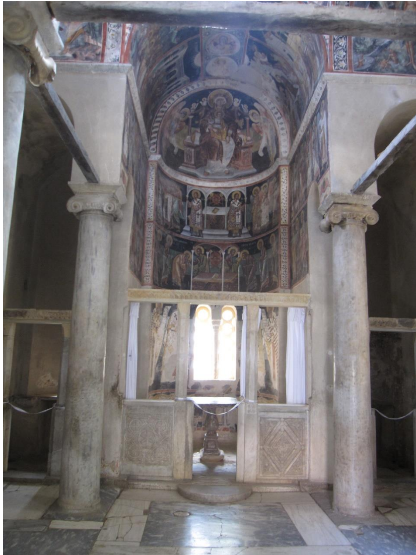
Εικόνα 2-10: Εσωτερική όψη του Ιερού Βήματος. Φαίνονται το μαρμάρινο τέμπλο και η κεντρική κόγχη με το δίλοβο παράθυρό της. Παρατηρείται ότι η κεντρική κόγχη αποτελεί σχεδόν συνέχεια του κύριου διαμήκους κλίτους, με ένα άλμα των 10 cm.
