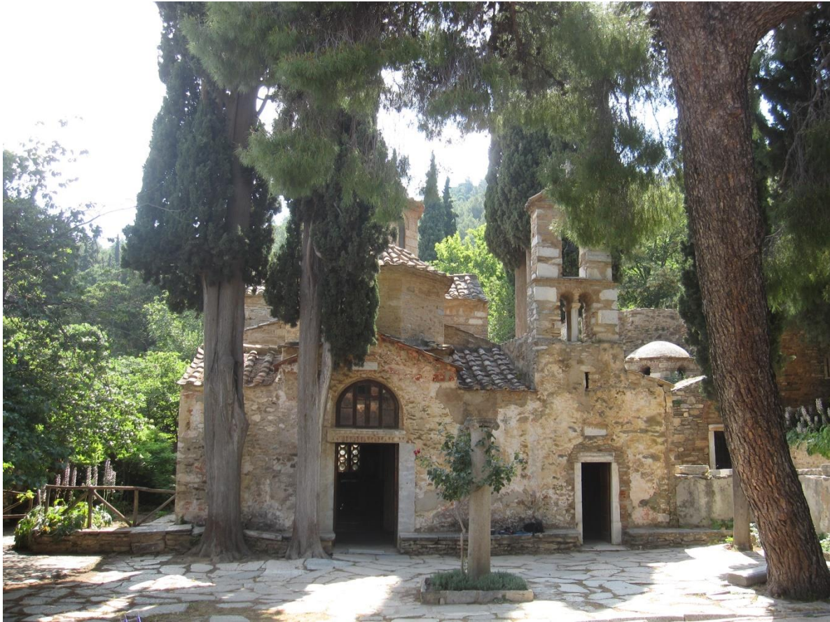
Εικόνα 1-1: Δυτική όψη του Καθολικού της Ι.Μ. Καισαριανής
