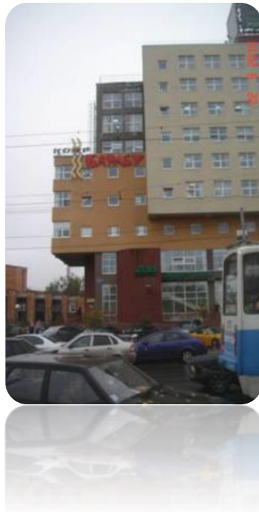
Εικόνα 2.40: Teledom κτήριο Πηγή: Vandysheva, 2012
